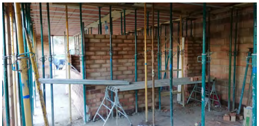
Aixecament tancaments cuina edifici barra 1, 1ª
