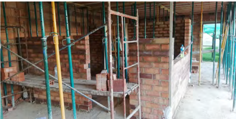
Aixecament tancaments cuina edifici barra 1, 1ª FASE
