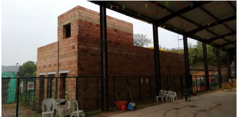
Façana d'accés i nord amb pista esportiva coberta
