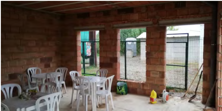
Visió interior de la zona del bar a la façana d'accés a l'edifici
