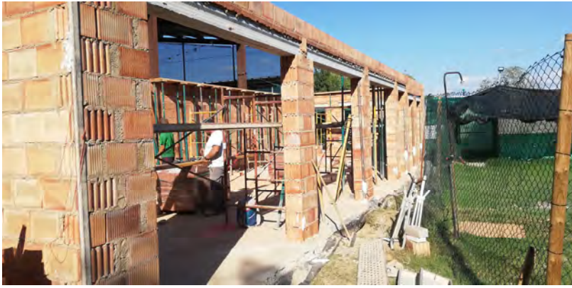
Aixecament estructura edifici barra 1, 1ª FASE
