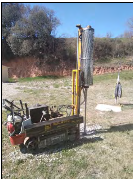
Fotografia 3. Vista de la màquina utilitzada en un dels assaigs de penetració dinàmica DPSH.
