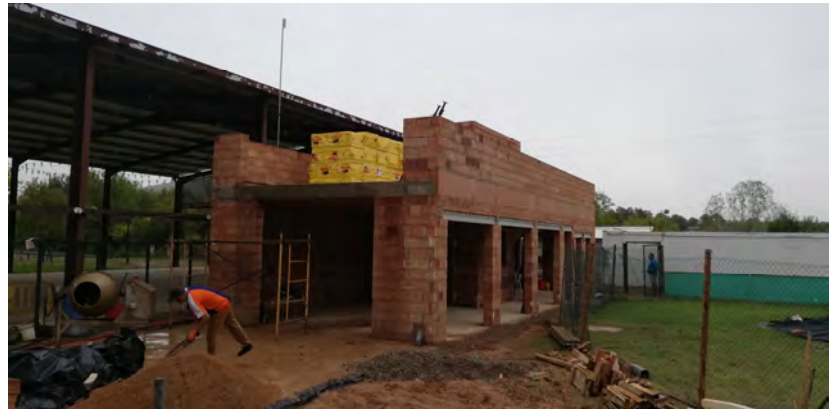
Aixecament forjat-terrasa edifici barra 1, 1ª
