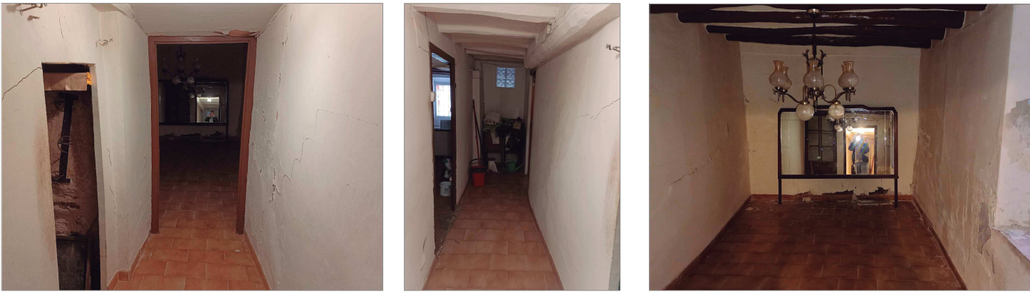
16.17.18. ENDERROC TOTAL DELS ELEMENTS CONSTRUCTIUS DE LA PLANTA ENTRESOL
