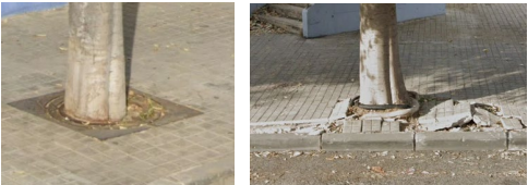
Escocell insuficient i esbombats
