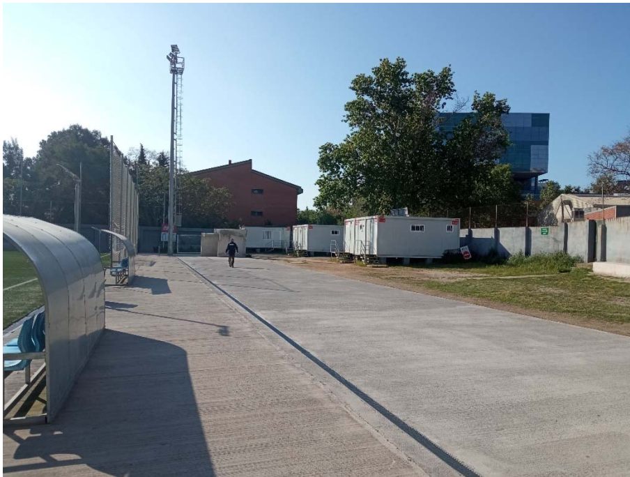
Fot.3: Vista lateral sense el volum de l'edifici de vestidors/grades amb els mòduls prefabricats
