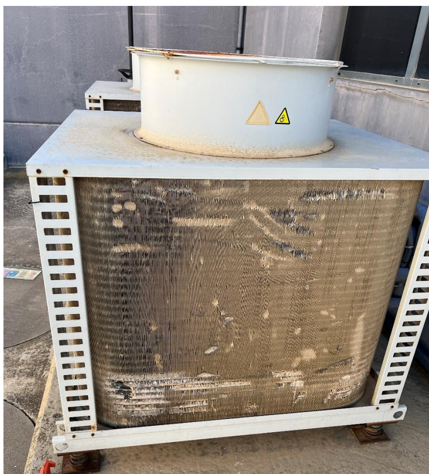
Imatge 5: Unitat partida (exterior) amb unitat interior de conductes - ITAM Llobregat
