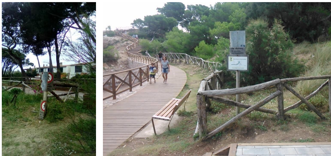
Presència de cartellera en mal estat
