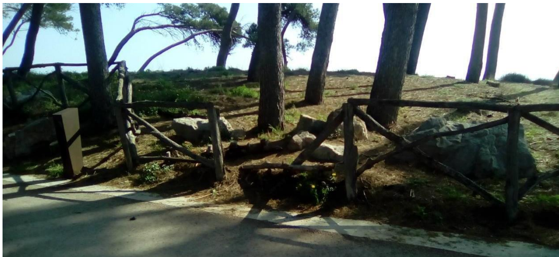
Presència tanques en mal estat o molt deteriorades
