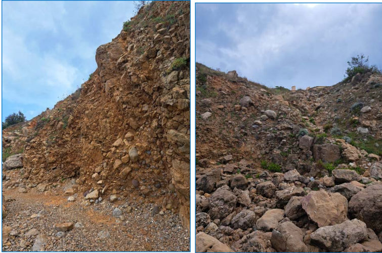
Fotos detall del material format per blocs i matriu llimosa d'edat miocè.
