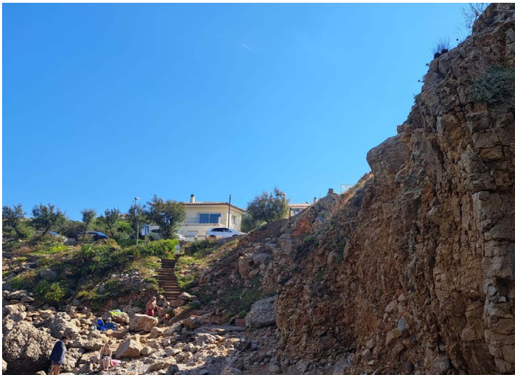
Foto 9. Vista de les escales d'accés a la platja i al peu del talús.
