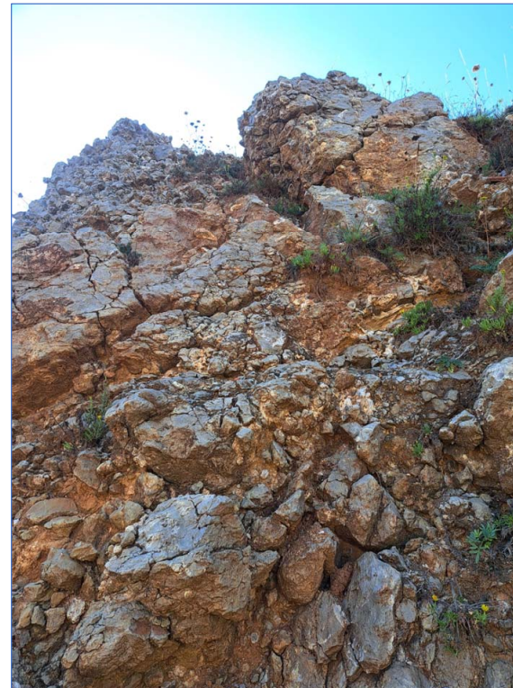
Foto 5. Detall de blocs rocósos inestables degut a l'elevat grau de fracturació.
