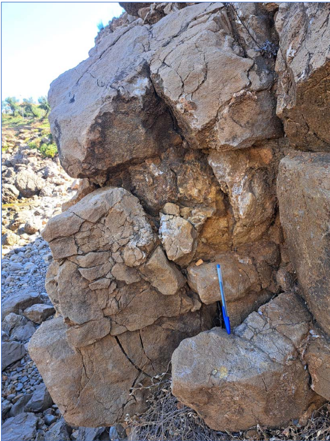
Foto 7. Detall de blocs rocosos inestables degut a l'elevat grau de fracturació.
