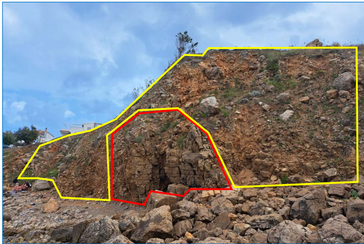
Vista del conjunt del talús diferenciant els dos tipus de materials.
