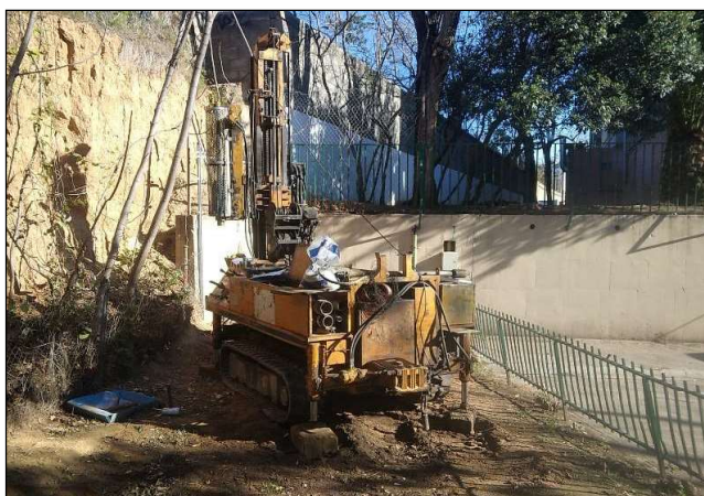
Fotografia 7. Vista de la màquina utilitzada en un dels sondeigs a rotació realitzats.
