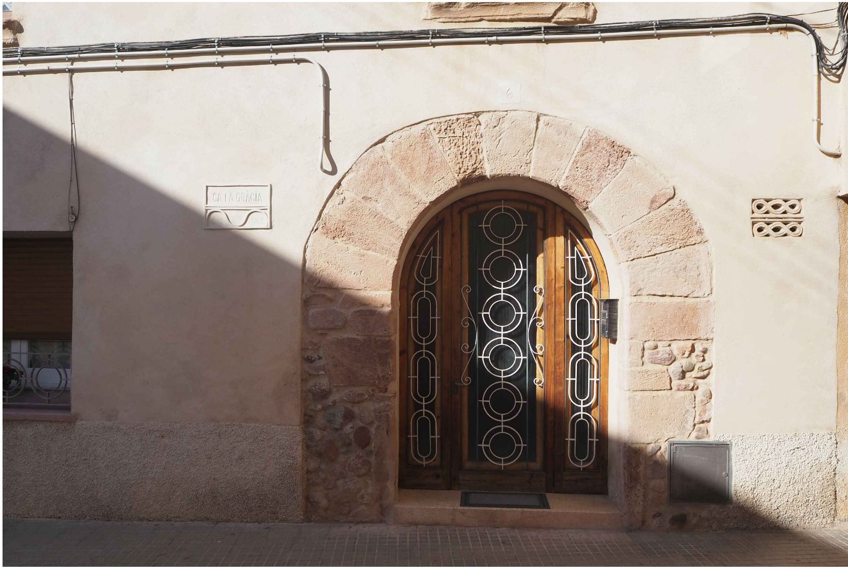
02 Porta d'accés habitatge nº 6
