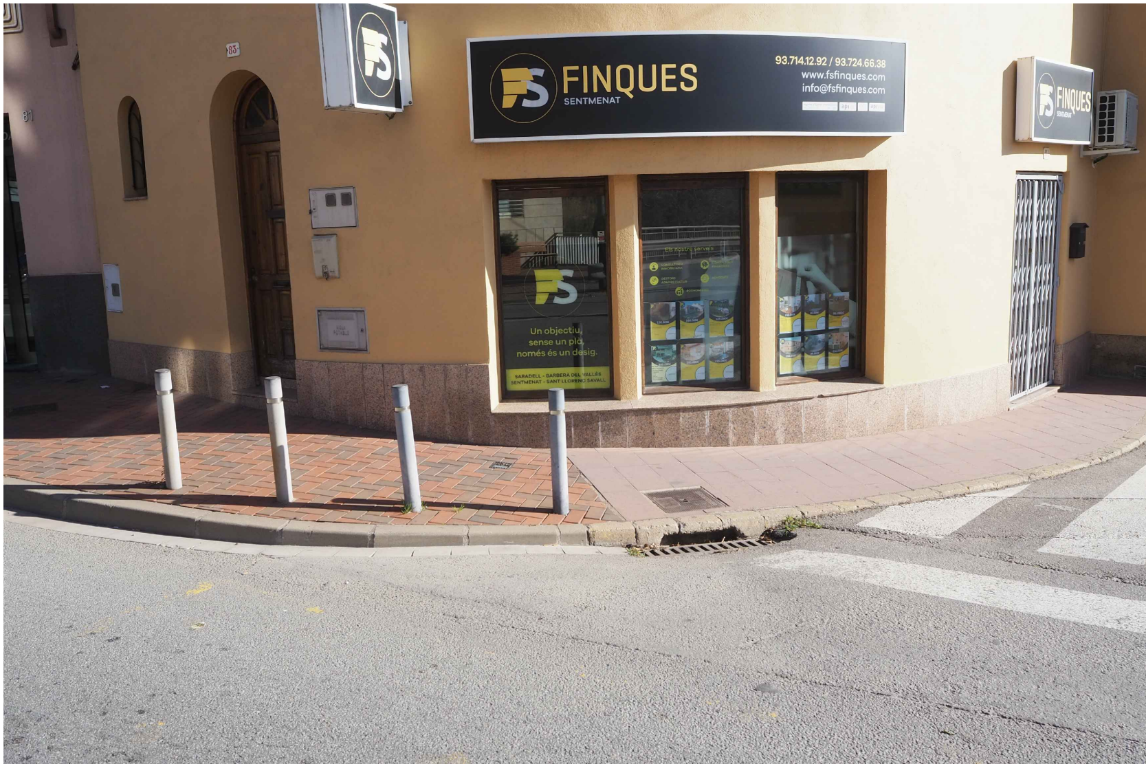
08 Canvi de paviment al xamfrà amb la carretera. Marxapeus Habitatges 206,57m - Local Finques 206,11m
