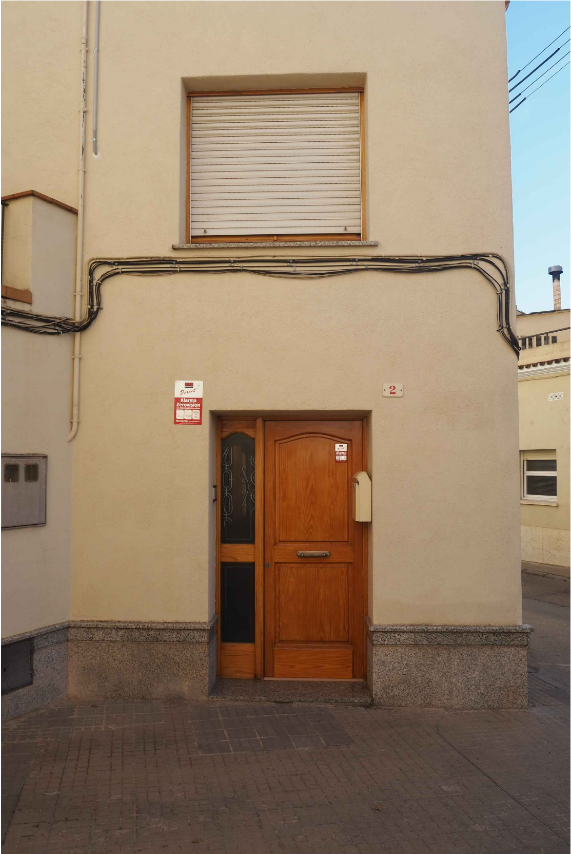
09 Façana habitatge nº 2
