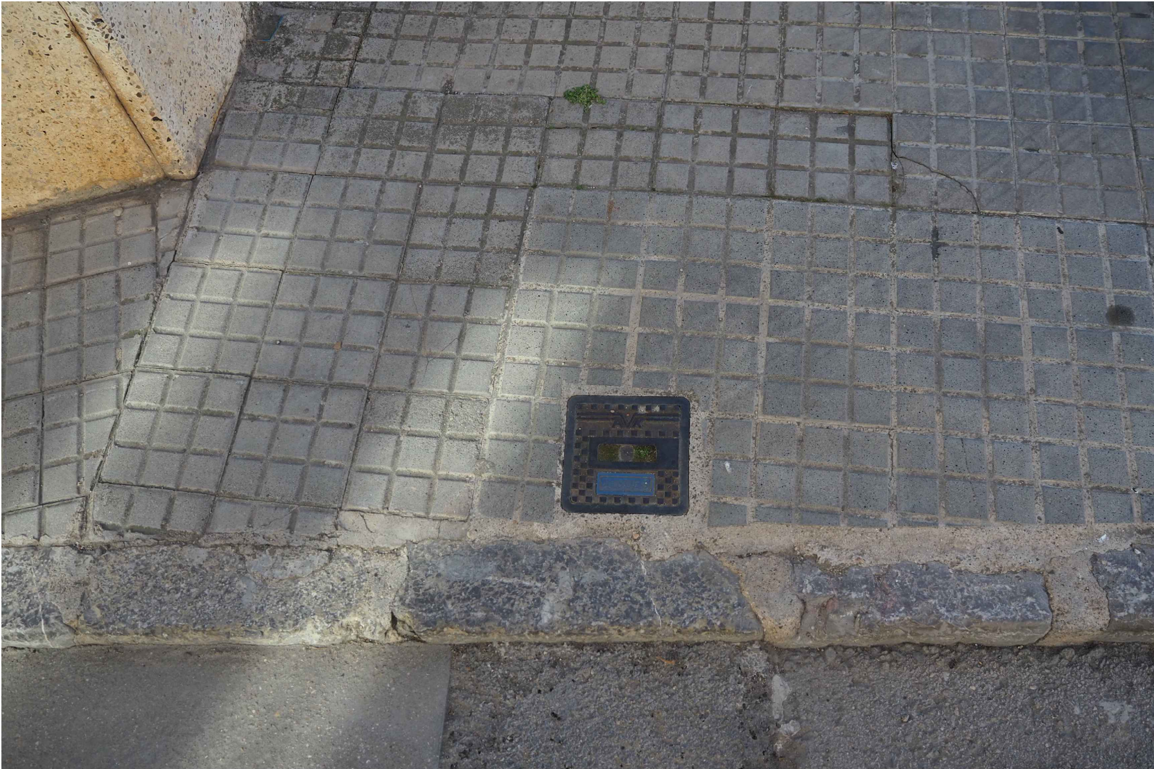
06 Arqueta d'aigua potable Passatge Ca la Gràcia - Zona Mirador
