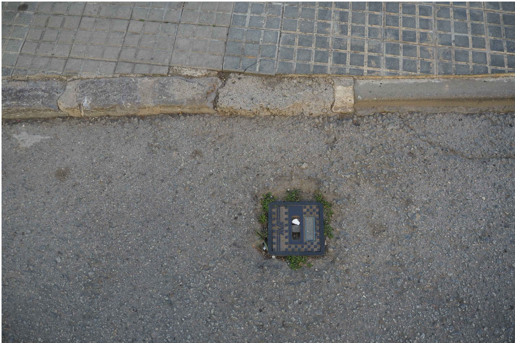
08 Arqueta d'aigua potable Passatge Ca la Gràcia - Zona Mirador
