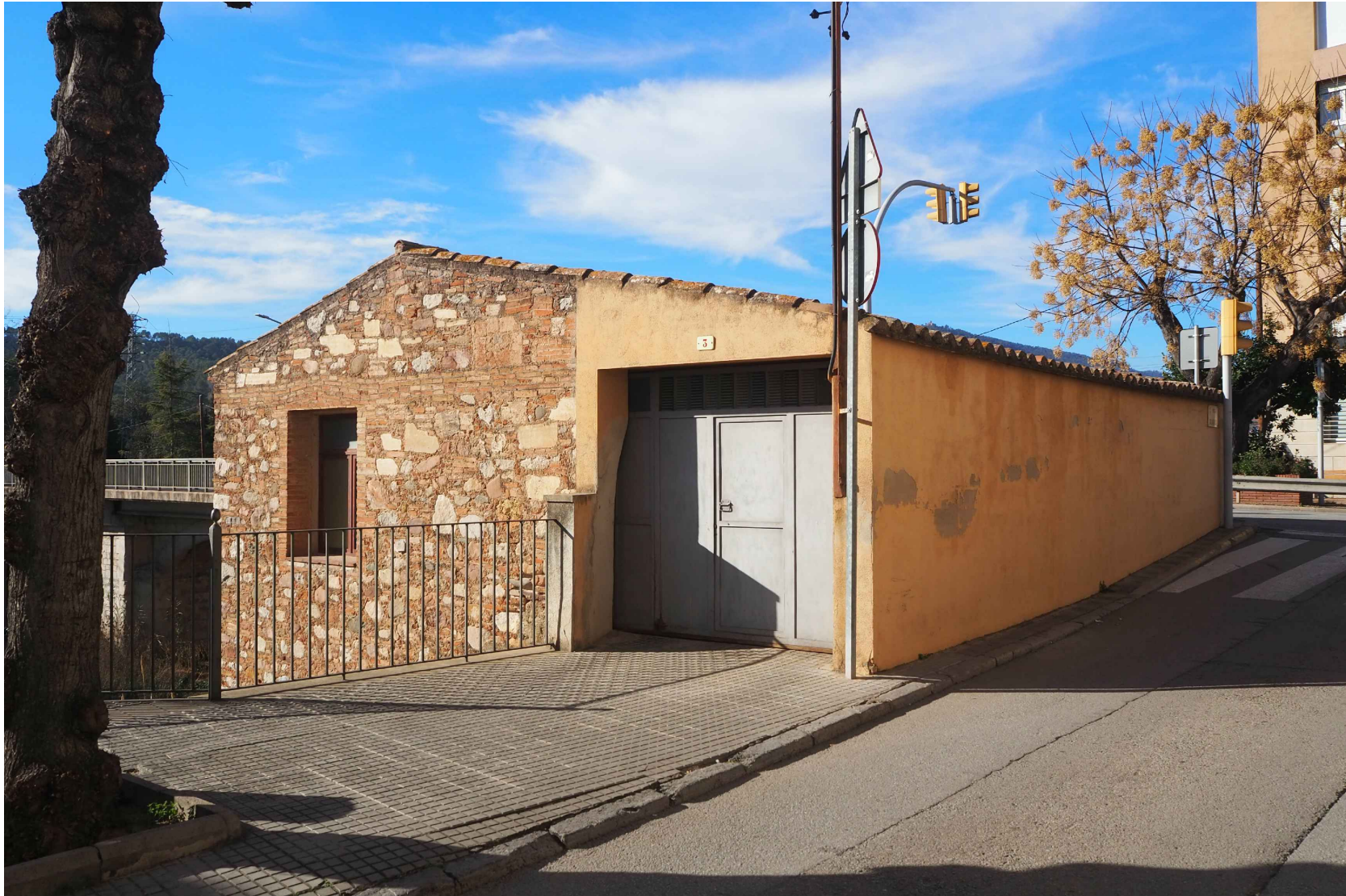
05 Porta de garatge entitat nº 3 Cota +205,88m
