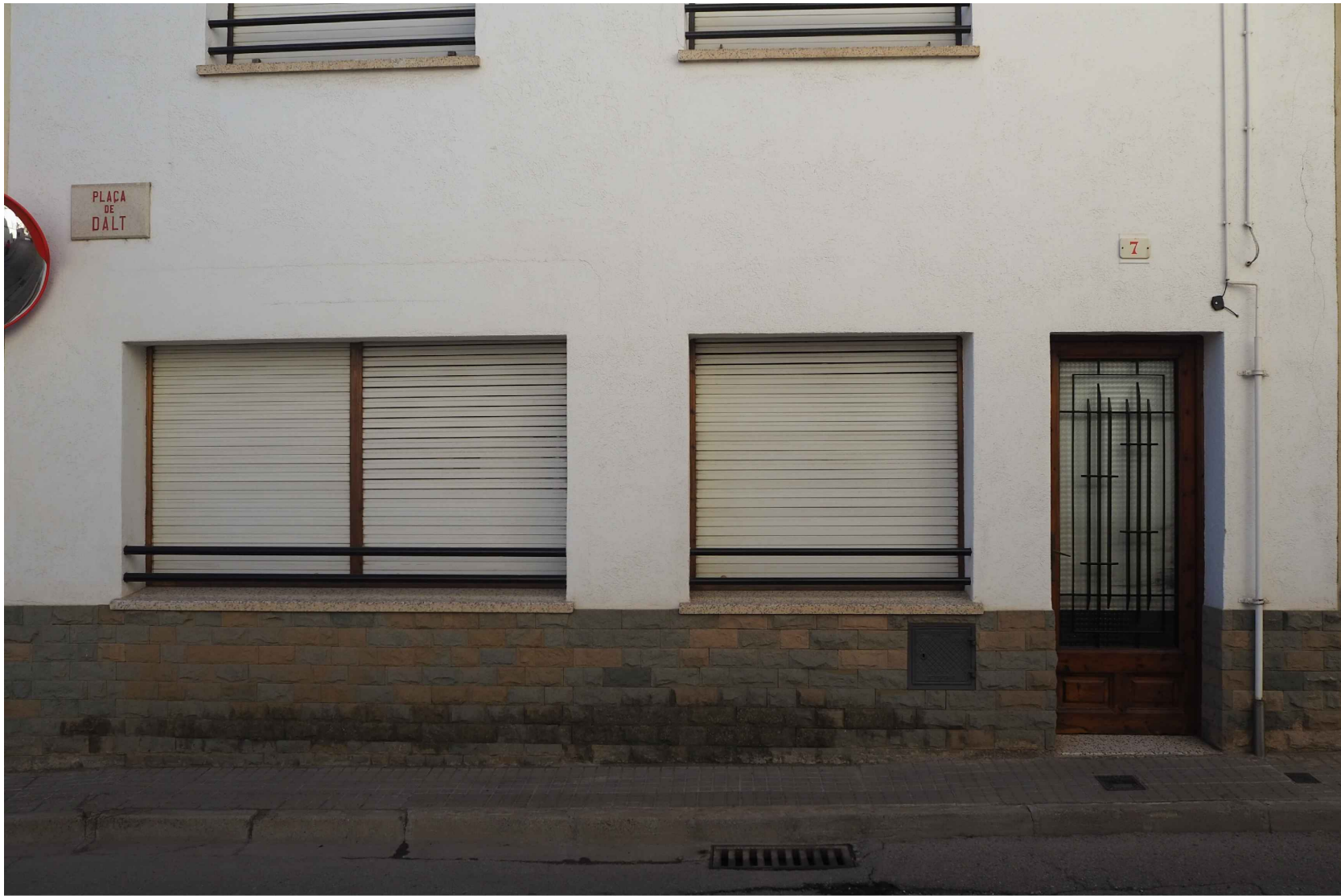
02 Façana habitatge nº 7
