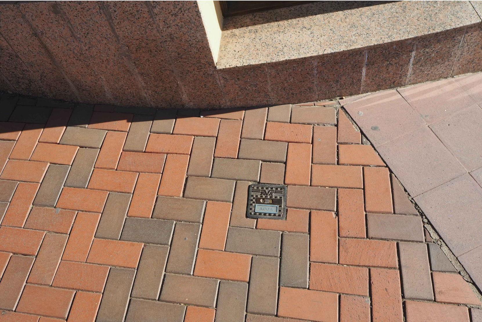
14 Arqueta d'aigua potable Passatge Ca la Gràcia - Ctra C-1413A
