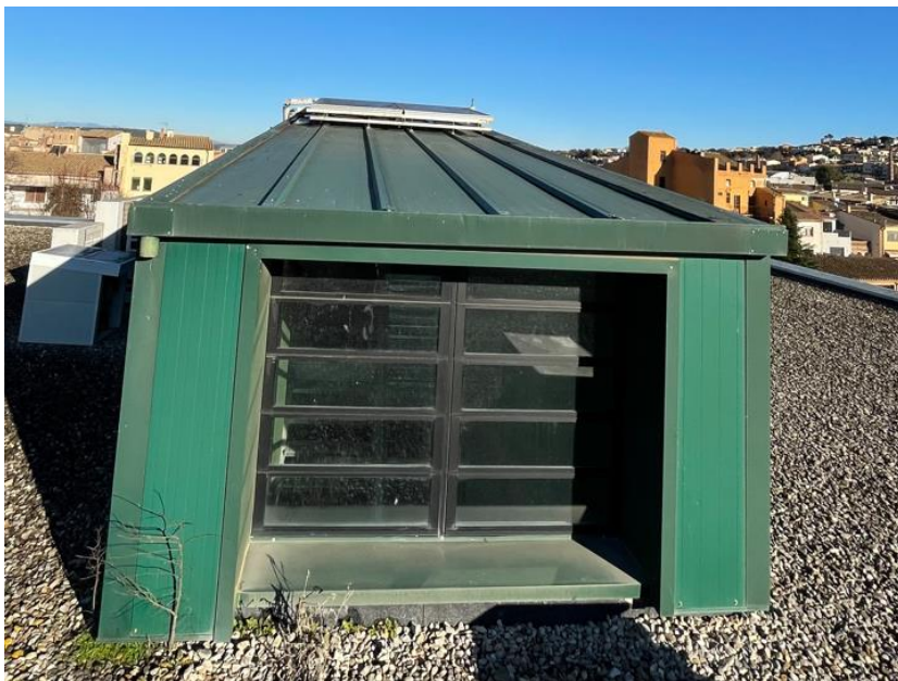
Foto 2. Detall panell coberta.
