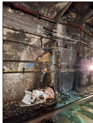
Foto 15: Filtració pantalla PK 106+890 v2.
