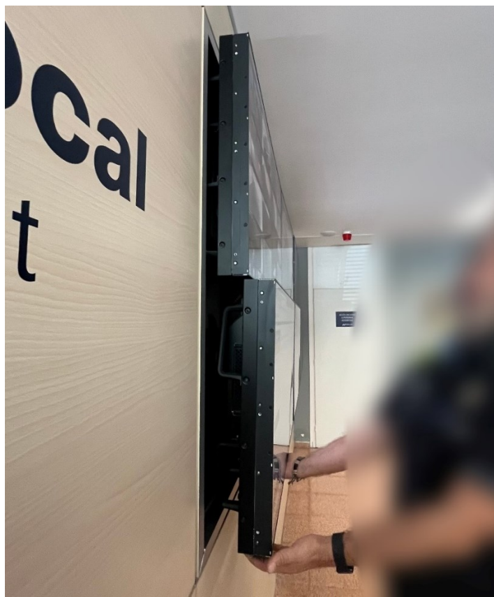
Il·lustració 1 - Part posterior i suport del videowall actual
