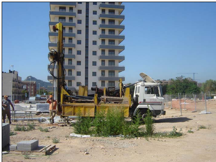
Foto 2: Realització del sondeig S-1 pel mètode de rotació.
