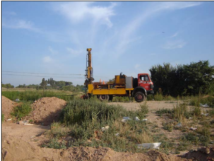
Foto 3: Màquina emplaçada al sondeig S-6.
