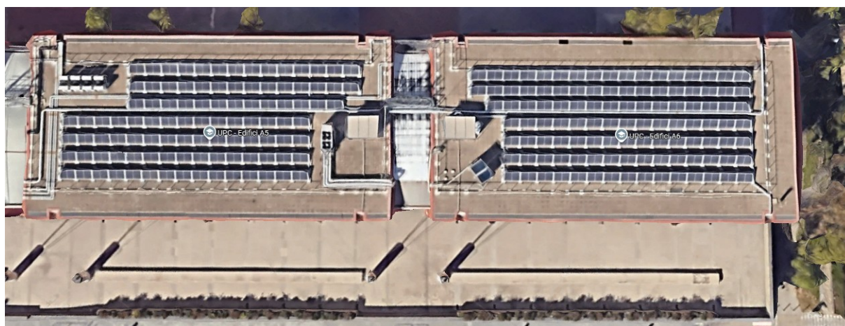
Vista aèria estat actual
