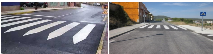
Pas de vianants elevat
