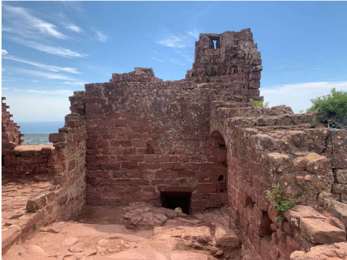
Àmbit B. Entrada al Recinte Sobirà
