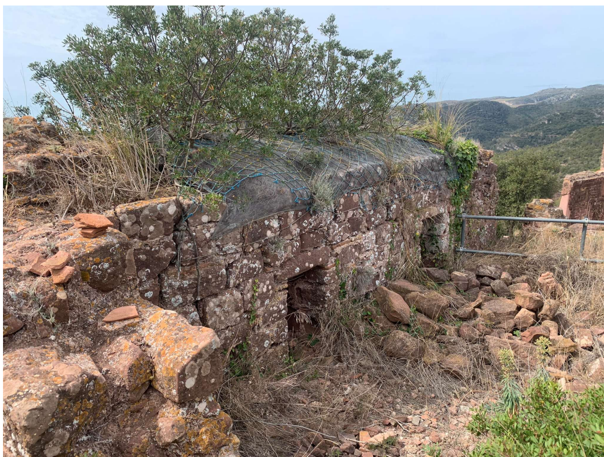
Recinte superior. Presència de vegetació en coronaments de murs. Font: Roger Guitart Domingo
