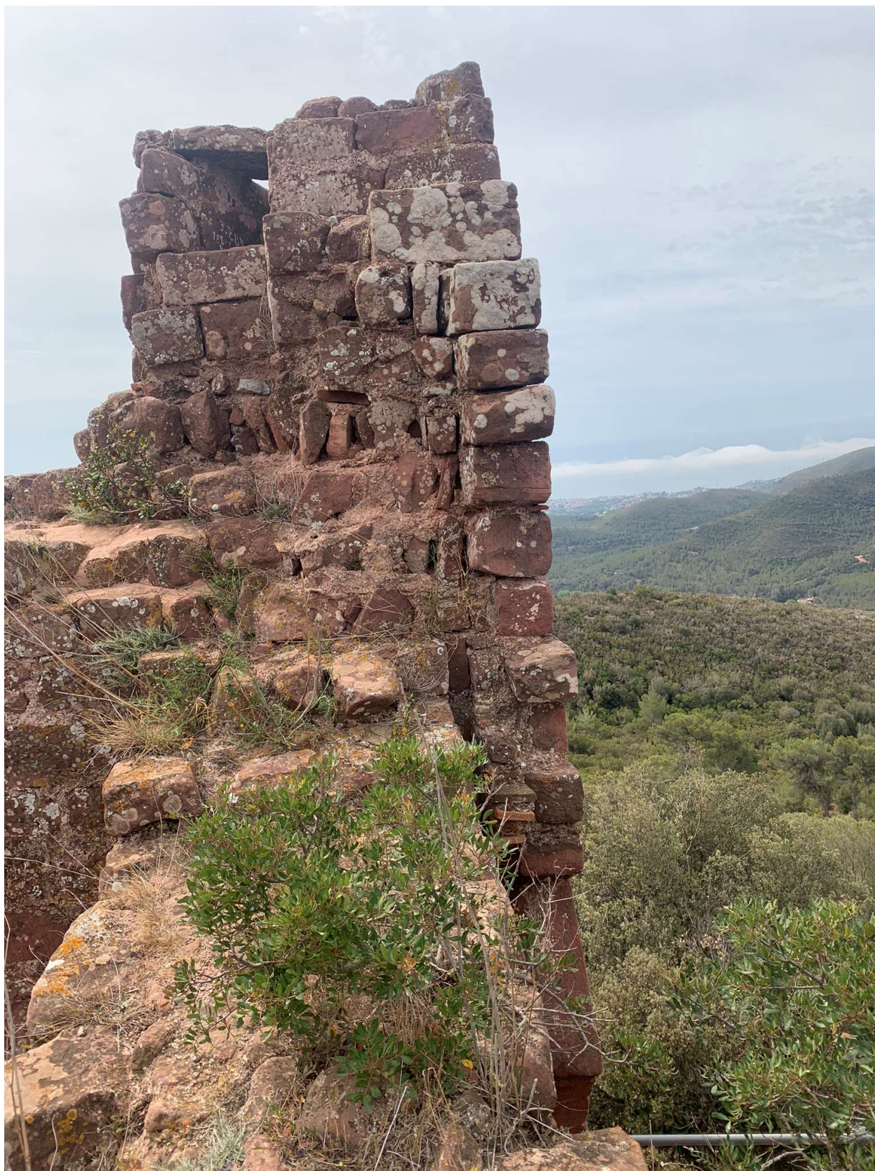
Recinte superior. Mal estat de coronaments i intradós de murs. Font: Roger Guitart Domingo
