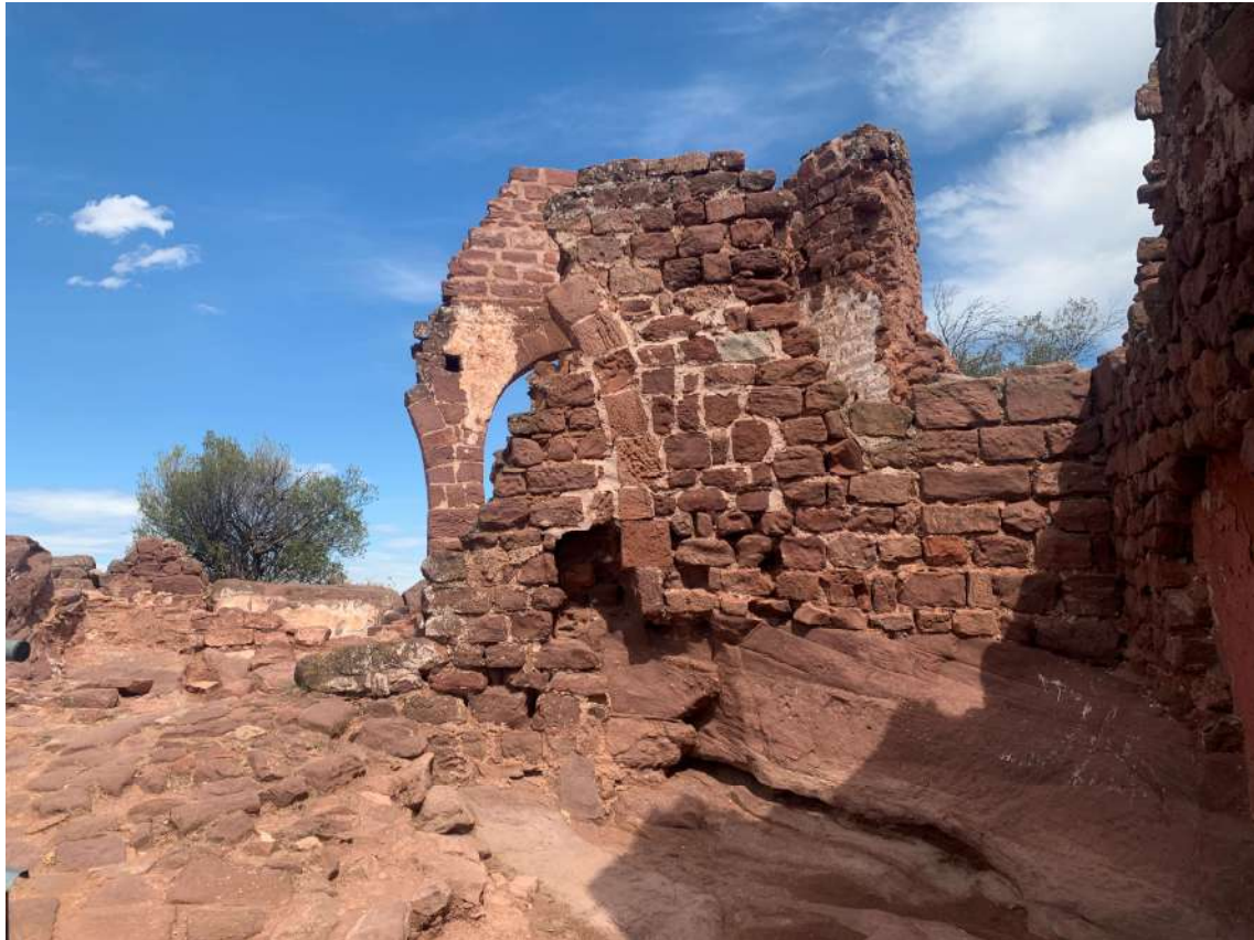
Àmbit H. Pati i cisterna
