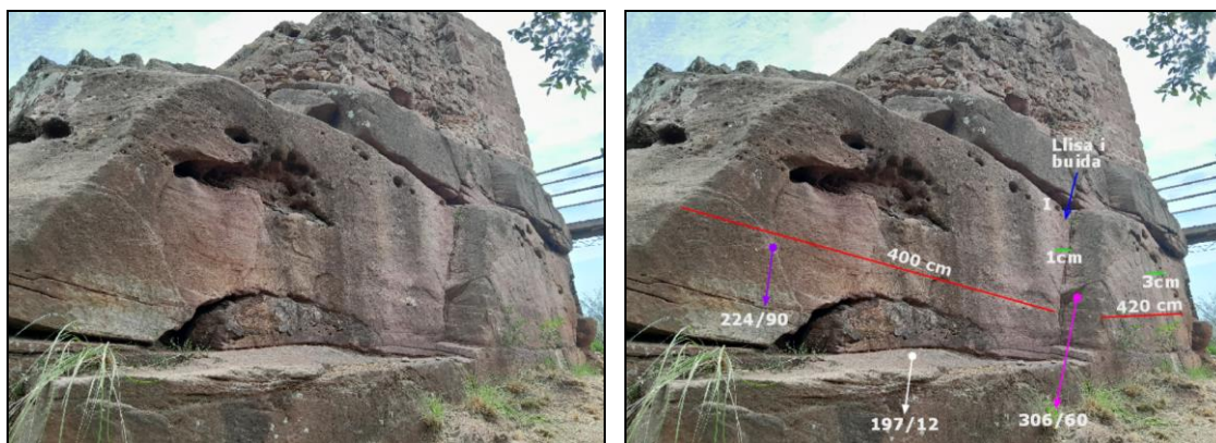
Fotografia 15 i Fotografia 16. Zona principal d'estudi de l'estació geomecànica i Anàlisi fotogràfic de les principals zones estudiades de l'estació geomecànica EG23.
