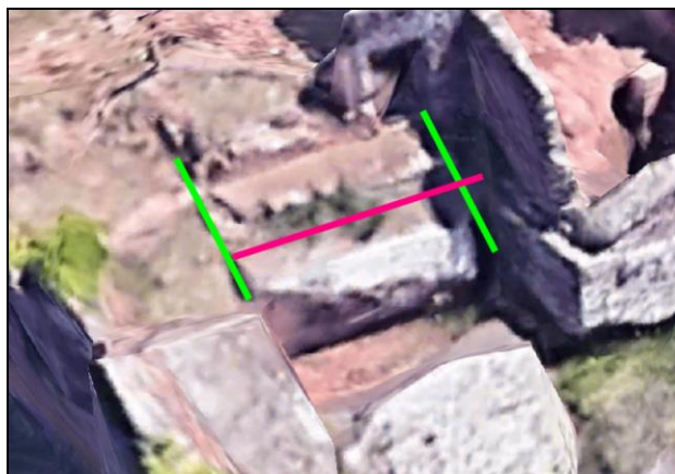
Figura 12. En verd el segellat de la D2 i en rosa, possible biga de descàrrega.
