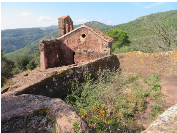
Cisterna del recinte jussà.
