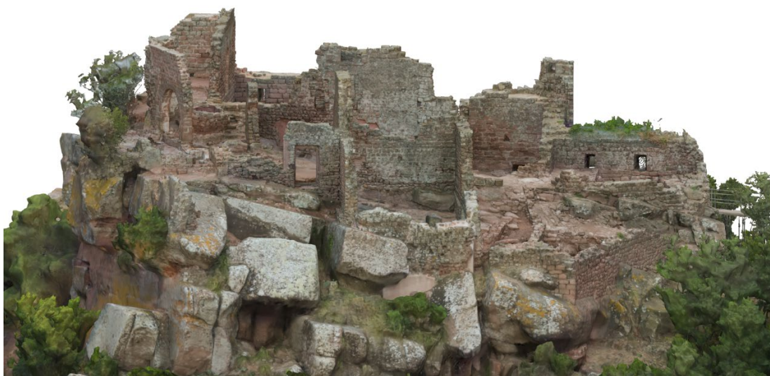
Vista panoràmica dels blocs de pedra a consolidar. Memòria tècnica de la digitalització 3D (Captae, octubre 2025).
