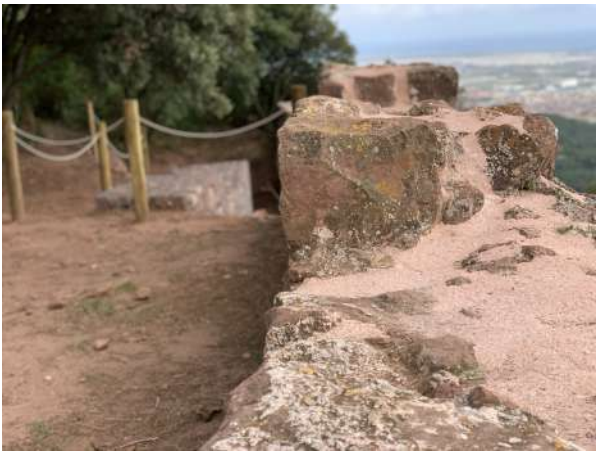
Rejuntat de coronament
