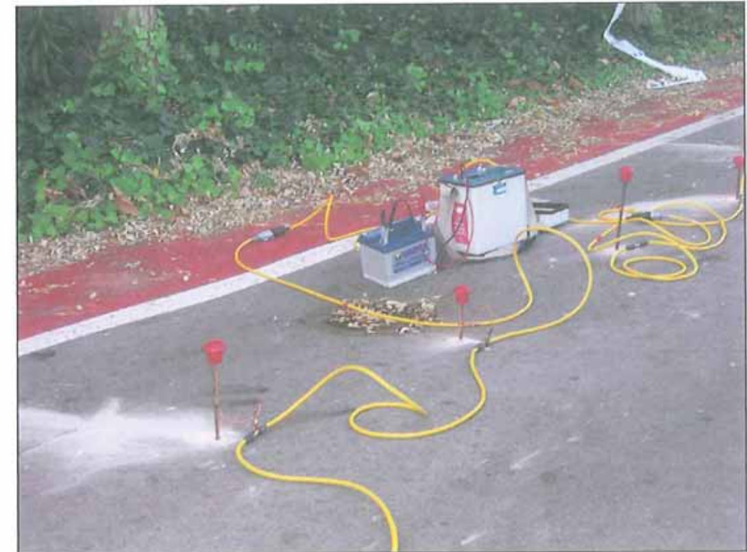
Figura 38. Fotografía del hundimiento en el vial de las Pistas Deportivas de la UB.
