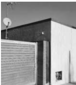
Façana sud-oest i sud-est
