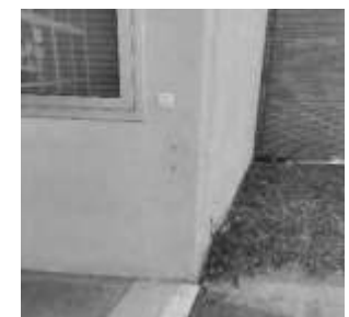
Façana interior oest
