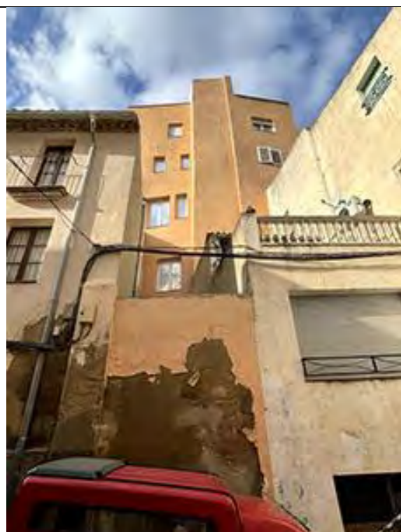
Vista de l'habitatge de la Plaça Major, 2 des del Carrer de Baix
