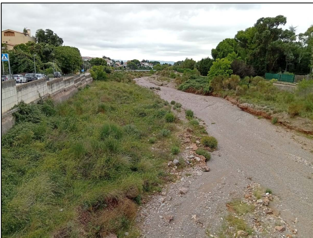
Imatge 6. Zona d'actuació on s'observen diferents nivells de graves que caldrà anivellar o redistribuir.
