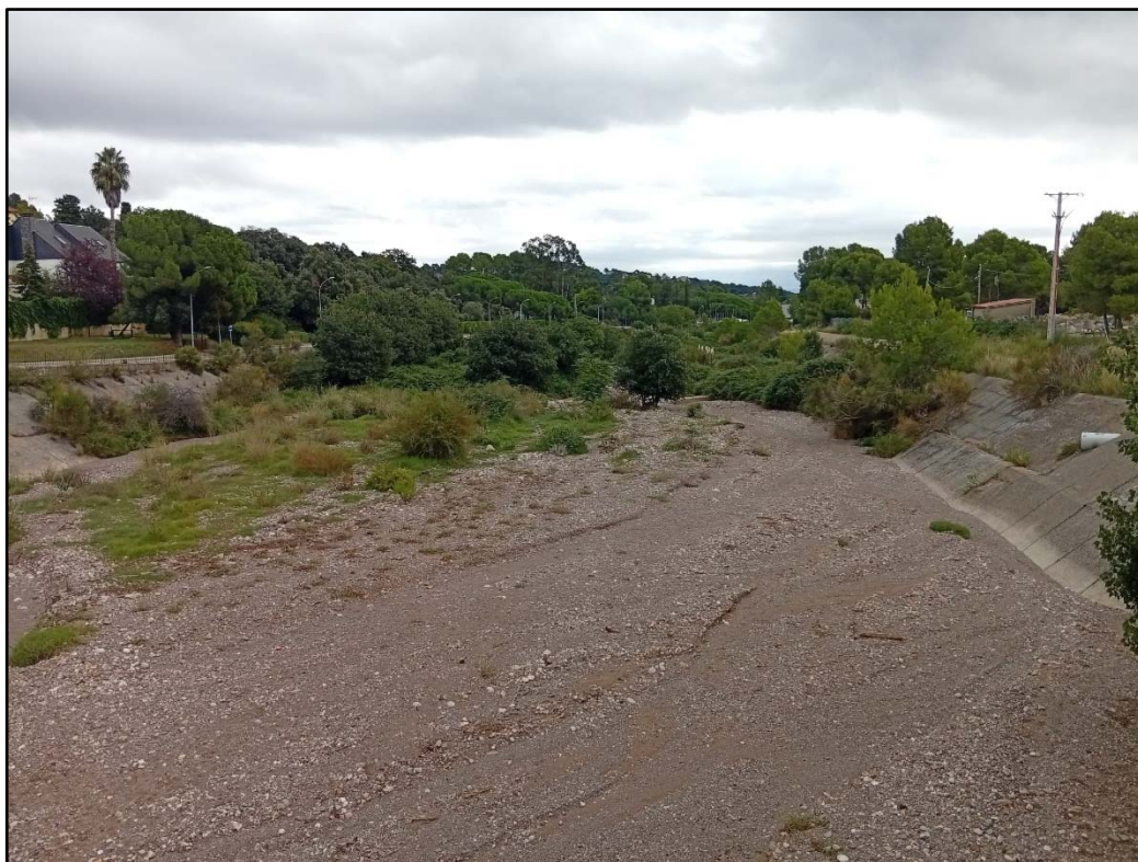
Imatge 1. Detall general de la llera, on s'observen les graves i els matollars
