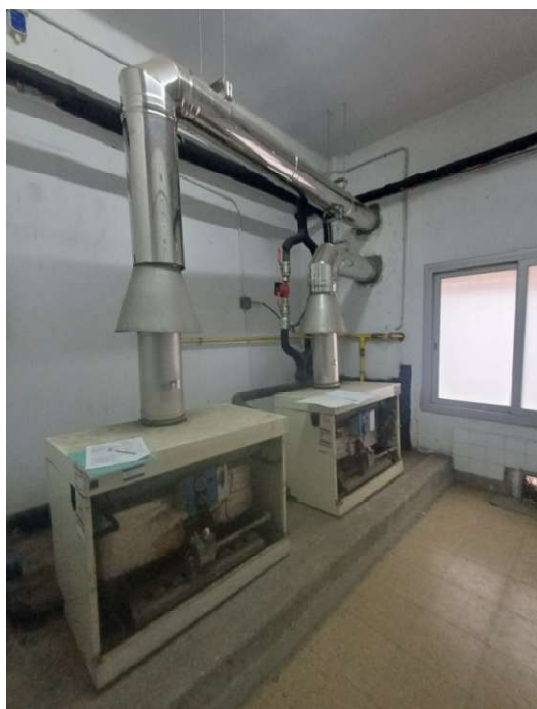
Fotografia. Calderes Atmosfèriques model GC-72 de la marca ROCA i grup de bombeig.
