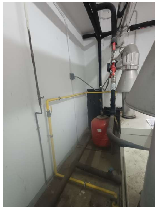
Fotografia. Calderes Atmosfèriques model GC-72 de la marca ROCA i grup de bombeig.
