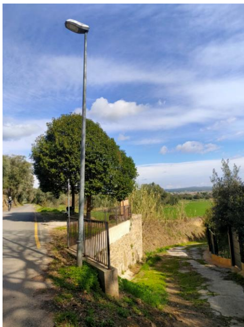
Vista general de l'àmbit intervenció
