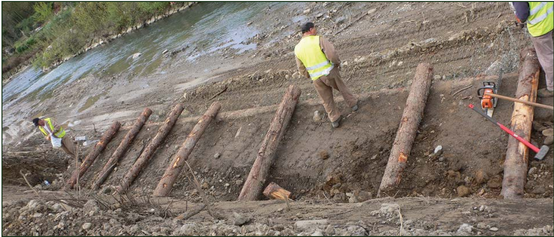
Muro Krainer en ejecución río Oria (Lasarte) I
