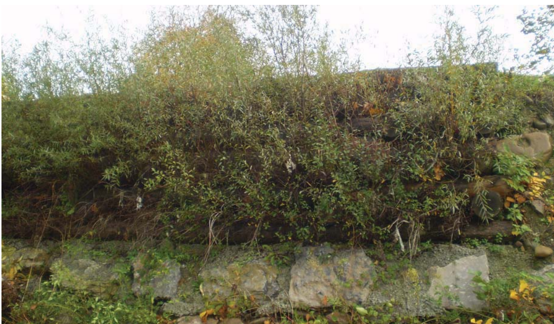
Muro Krainer en río Orre estado actual (Lasarte)
