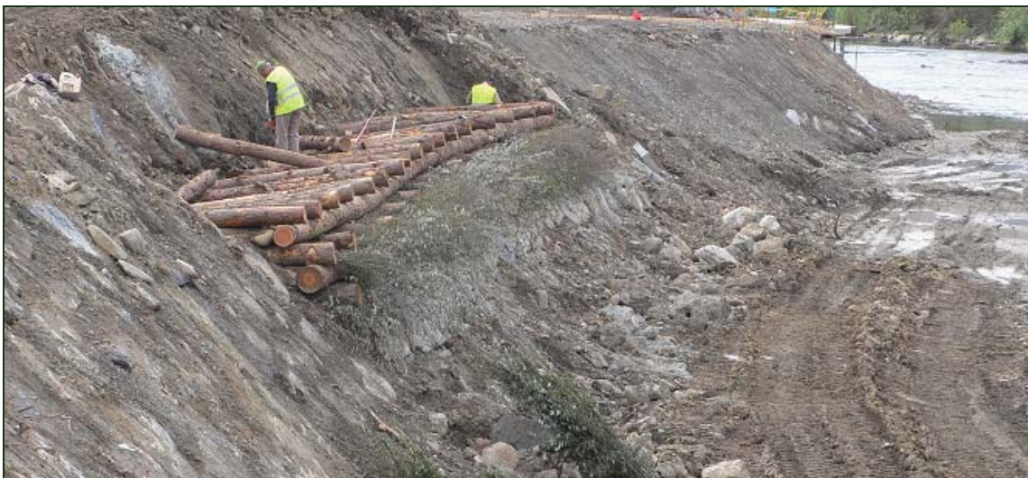
Muro Krainer en ejecución río Oria (Lasarte) II
