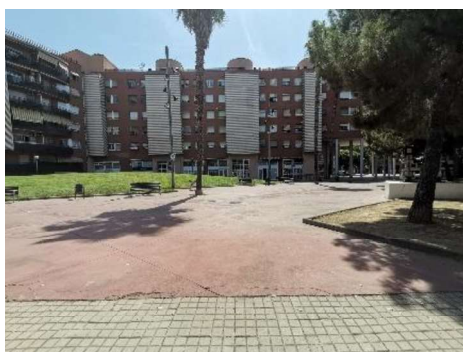
Vista SE- Plaça de la siderúrgia
