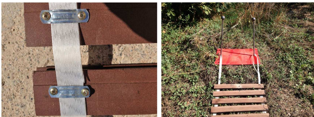
Detall de l'ancoratge del "fleje" en els llistons (esquerra) i detall de la fixació de la rampa en el terreny circumdant de la bassa.
