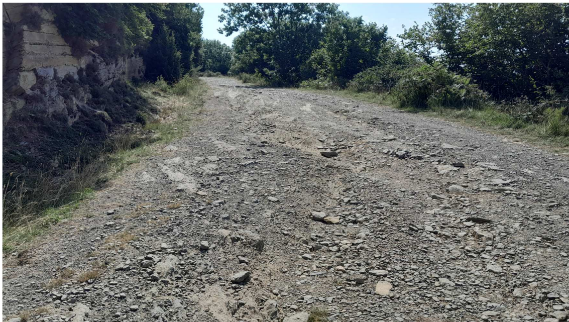
Exemple de l'estat del ferm de la pista principal d'accés a les forests.
