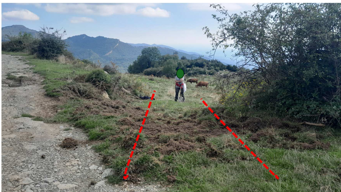
Punt d'entrada del camí principal al nou accés temporal. Poc moviment de terres. Posteriorment es restaurarà per evitar el pas de vehicles.
