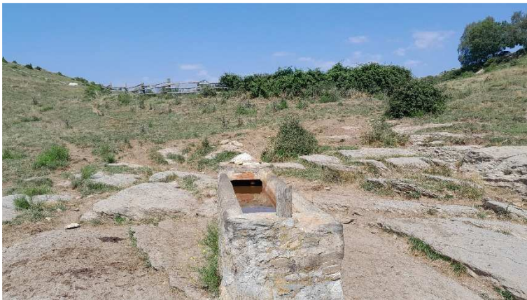
Abeurador de vaques existent al peu de la Bassa de Monars i zona per on s'engrandirà, terraplenant, la Bassa de Monars
