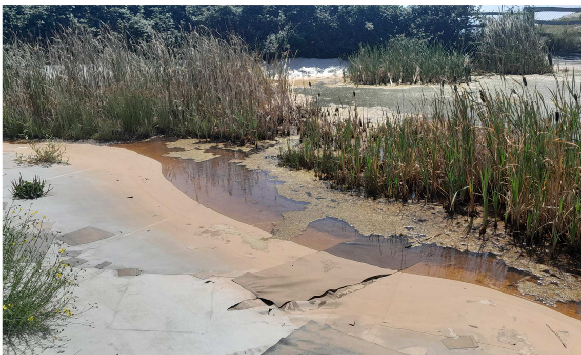
Impermeabilitzat actual de la Bassa de Monars, deteriorat.
