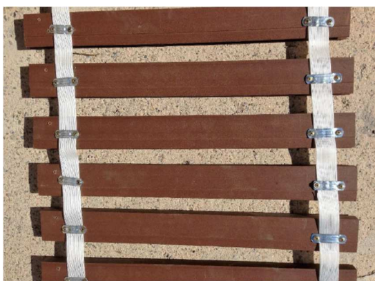
Detall de la part superior dels llistons de la rampa anti-ofegament (esquerra) i de la posterior dels llistons (dreta)
