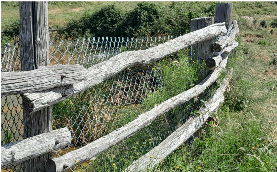
Tanca perimetral de la bassa de Monars, existent, a desmuntar.
