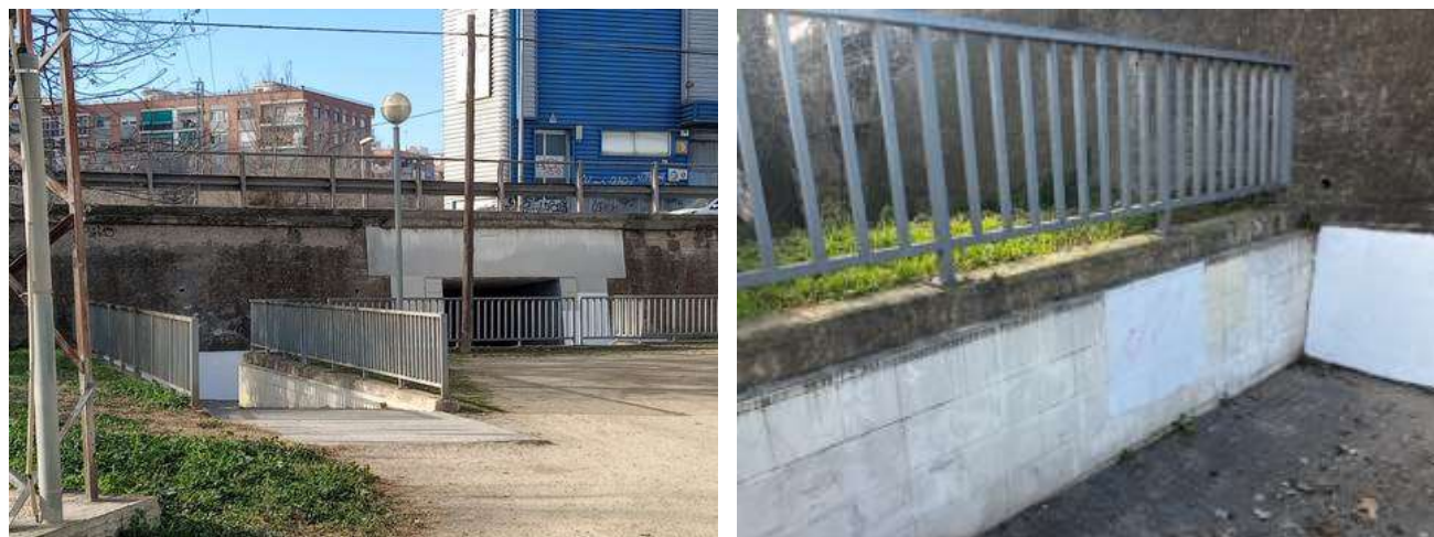
Imatges que mostren el pas inferior existent sota la N-150 per hi arriba l'aigua desbordada
