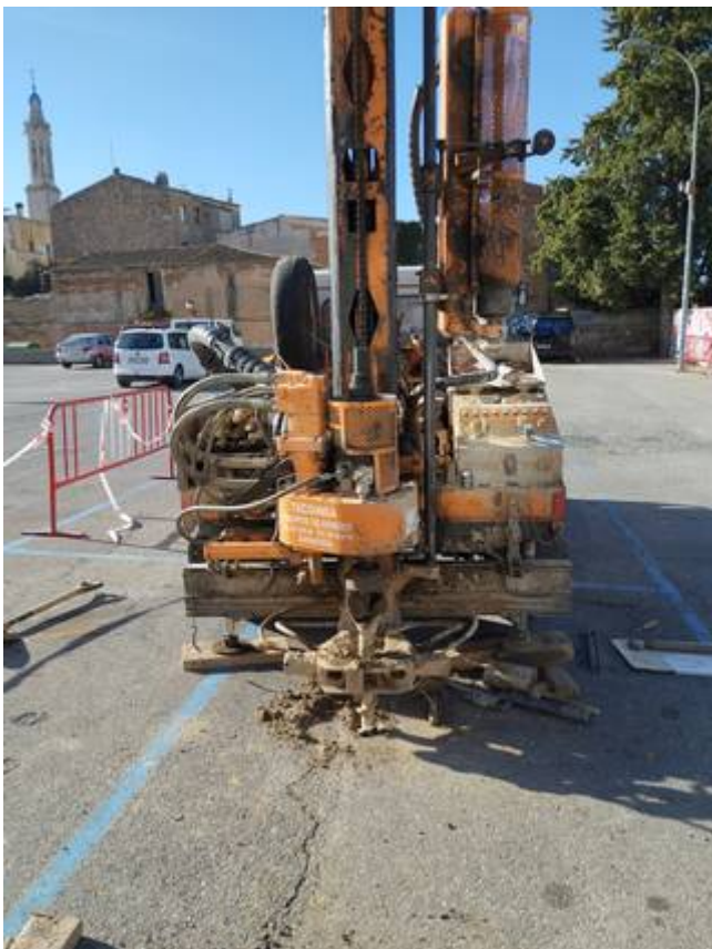
Vistes de quatre dels vuit sondeigs realitzats a la parcel·la objecte d'estudi, P-2 del tipus DPSH i, S-1, S-3 i S-4 del tipus Rotació helicoidal.
