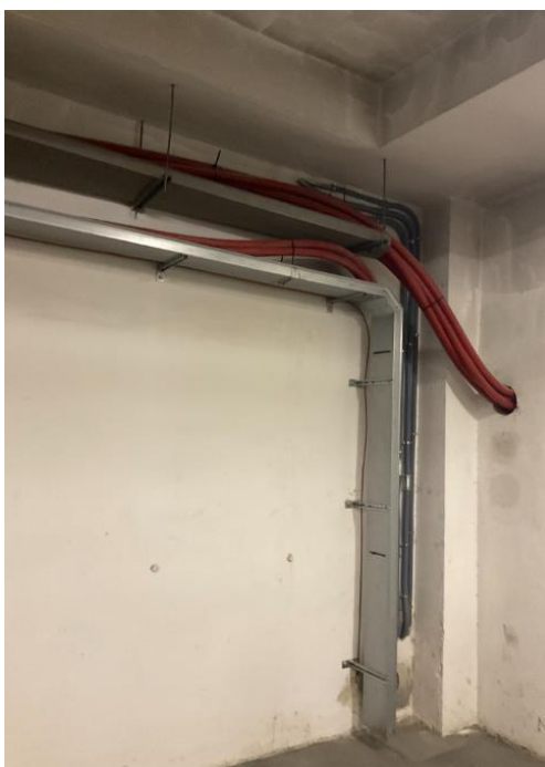
Imatge de la escomesa en MT dins del CT de Imperial Tàrraco
