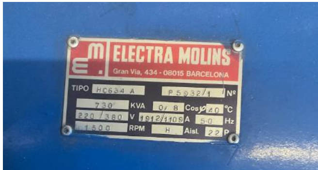
Placa de característiques del grup electrogen.
