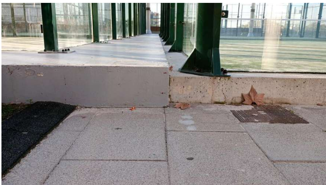
Ancoratges estructura tancament pista de pàdel
