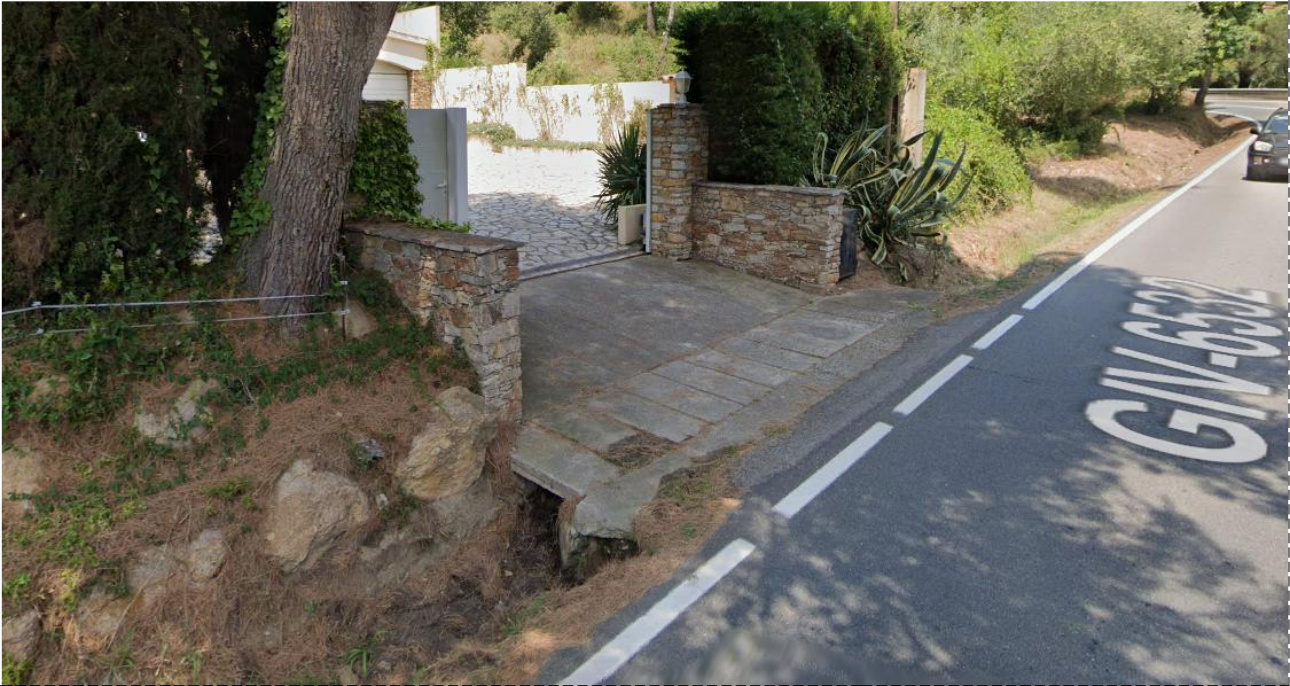
DRENATGE CANAL FORMIGÓ
