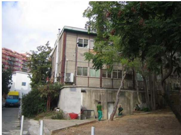
Imatge d'un dels mòduls prefabricats dels darrers temps
