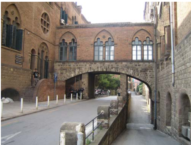
Hospital de Sant Pau. Exemple de ponts i galeries de comunicació
