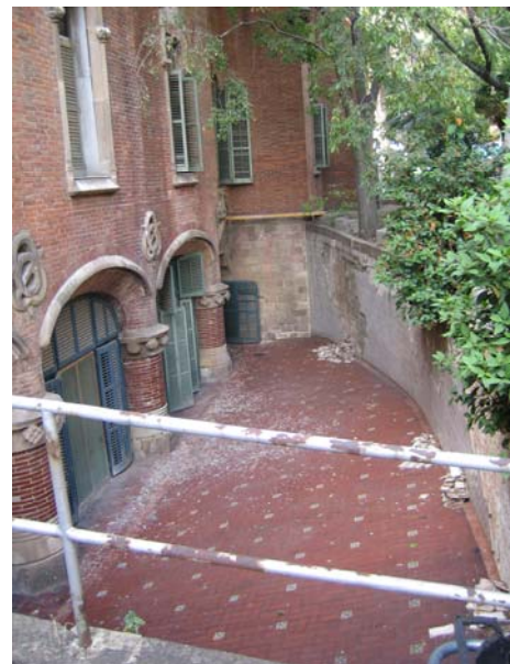
Detall del pavelló de la Mercè, construït en aquest primer moment
