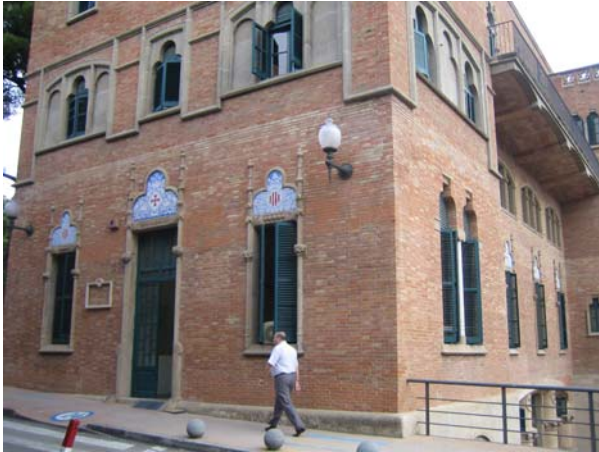
Pavelló de Santa Victòria. Façana posterior.
