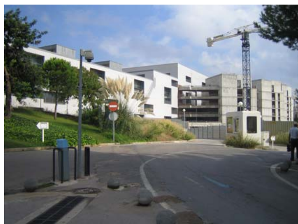
Imatge de les noves construccions hospitalàries
