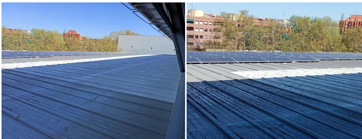
Imatges coberta lleugera
