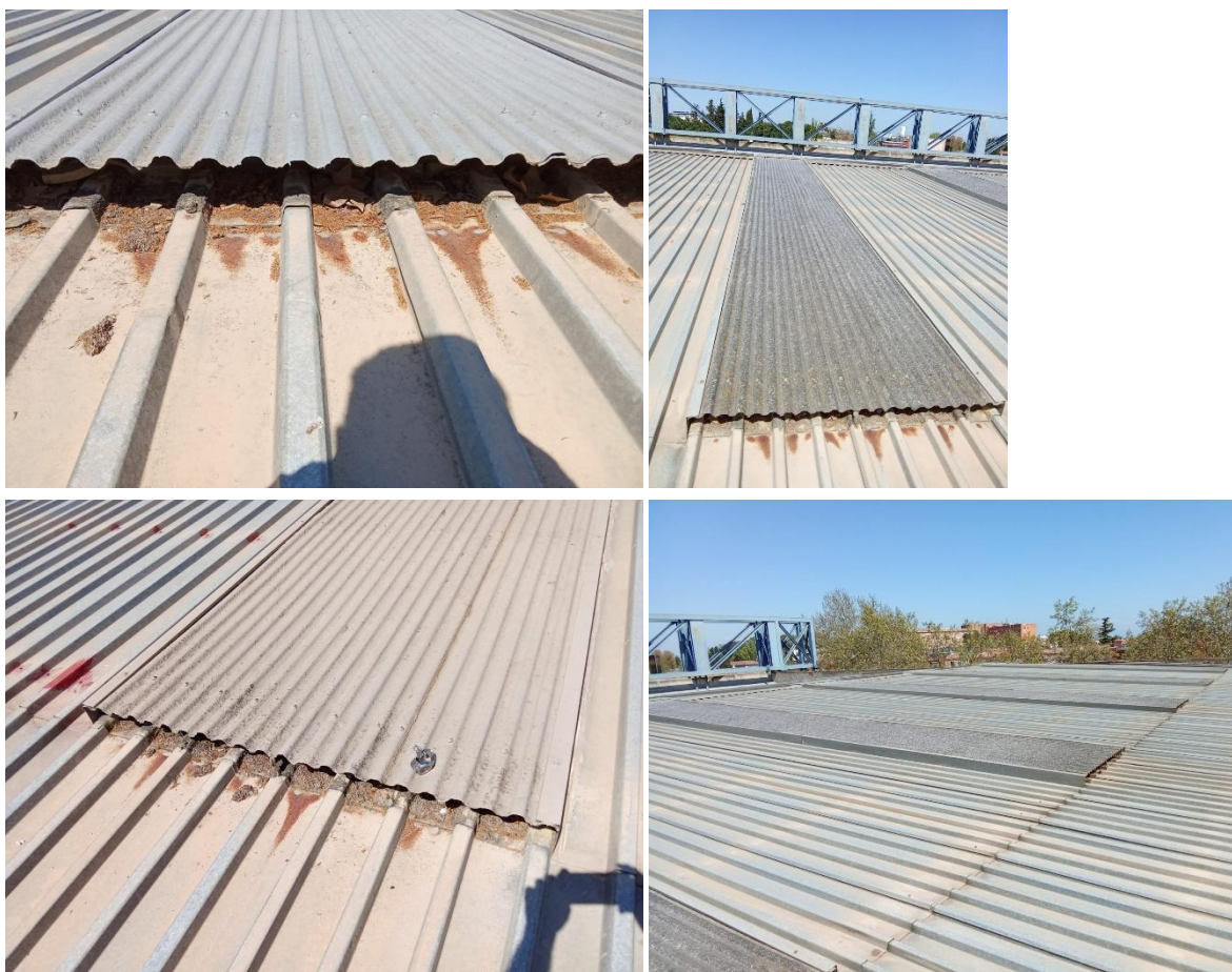
Imatges coberta lleugera
