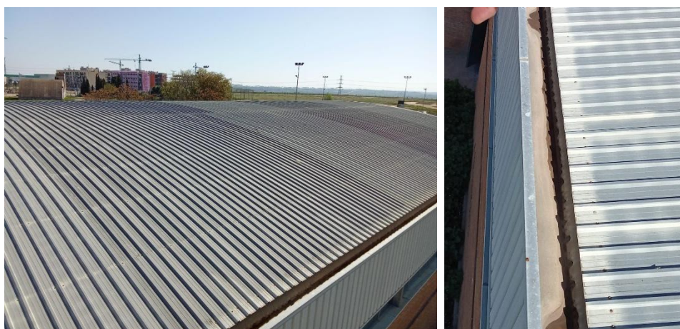
Imatges coberta lleugera
