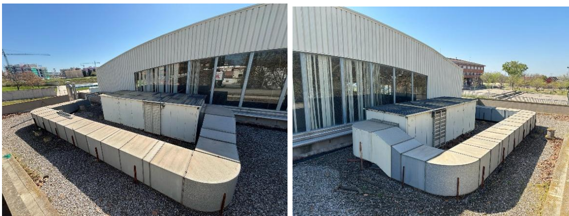
Imatges coberta plana
