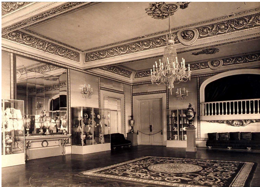
Vista de la Sala de Porcellanes, en la que es pot distingir el gran mirall i la consola sobre mènsules que substituï la falsa xemeneia i el retrat del Rei de la sala de Música original. Font: AFB. 49673.
