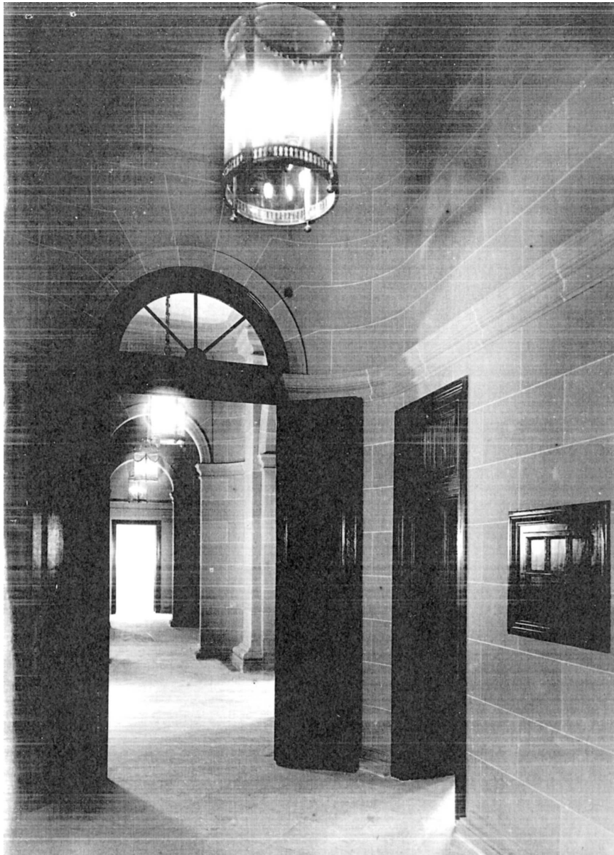
Les pintures de les parets del corredor original d'època alfonsina imitava un carreuat regular de pedra a imitació dels vestíbuls típics dels "hôtels particuliers" de París.
