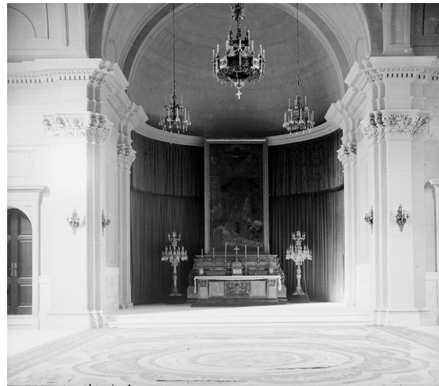
La Capella reial en el moment de la inauguració de l'edifici, segons fotografia d'Esteve Puig i Pascual realitzada l'any 1928. Vegi's que el presbiteri es tancava amb un mur circular i una volta absidal en quart d'esfera i que els llums originals no eren de vidre, sinó salomons de ferro forjat.
