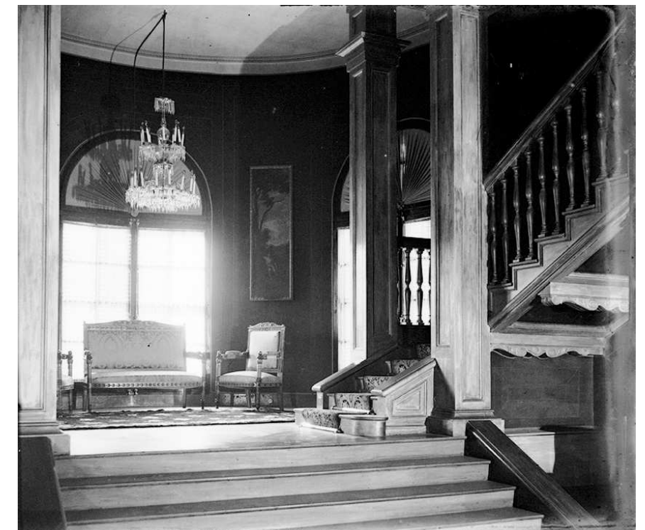
Vista parcial de l'escala privada l'any 1928, segons fotografia d'Esteve Puig Pascual. En origen aquest espai comptava amb un desnivell a la zona absidal, destinada a replà de la gran escala d'estil anglès que comunicava la planta baixa amb la primera.
