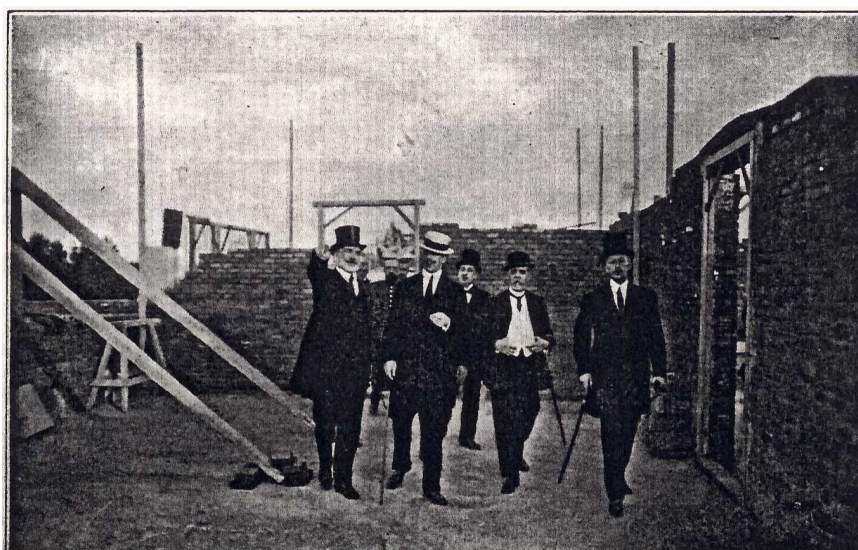
EN LAS OBRAS DEL PALACIO REAL : Su Majestad recorriendo el piso superior del edificio
