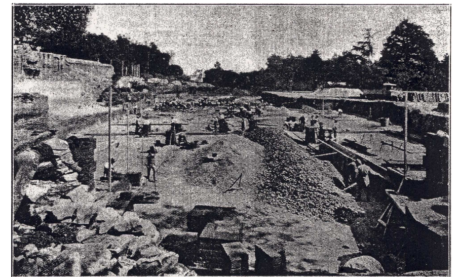
VISTA PARCIAL DE LAS OBRAS DEL PALACIO REAL
