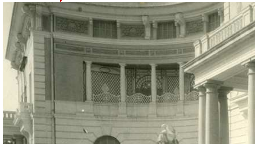
Fotografia realitzada l'any 1925 per la Sociedad de Atracción de Forasteros. En ella s'hi pot veure en detall les gelosies que tancaven les galeries porticades de la planta principal, així com els enreixats de roserar que cobrien llurs murs de tancament.
