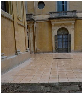
Paviment de gres
