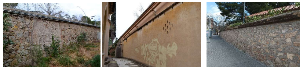
Imatges actuals interiors i exterior del mur
