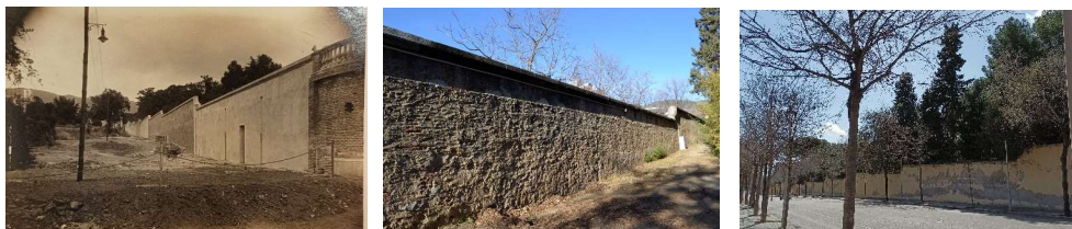
Imatge del mur al carrer John Maynard Keynes (F.Coac Nebot 1925) i vista interior i exterior actual
