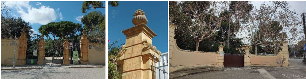
Imatges actuals de les portes d'accés des del carrer J.M. Keynes
