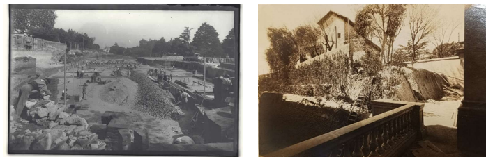
Imatges del període de construcció del Palau (F.Branguli 1921-1923) i edificacions que van ser enderrocades (F.Coac Nebot 1925)
