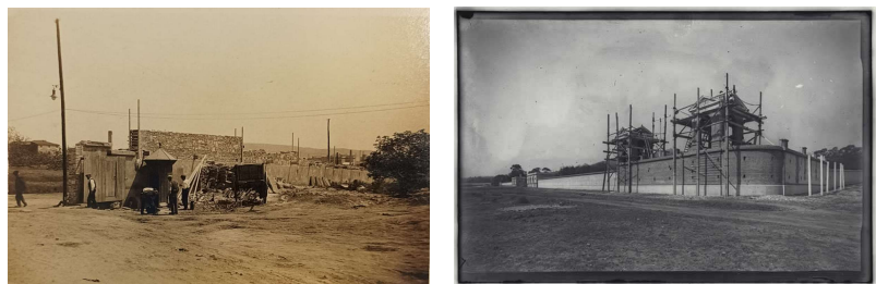
Imatge del mur a l'Avinguda Diagonal (F.Coac Nebot 1925) i construcció del Pavelló (F.Branguli 1921-1923)
