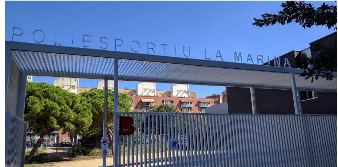
Porta Principal de l'equipament municipal
