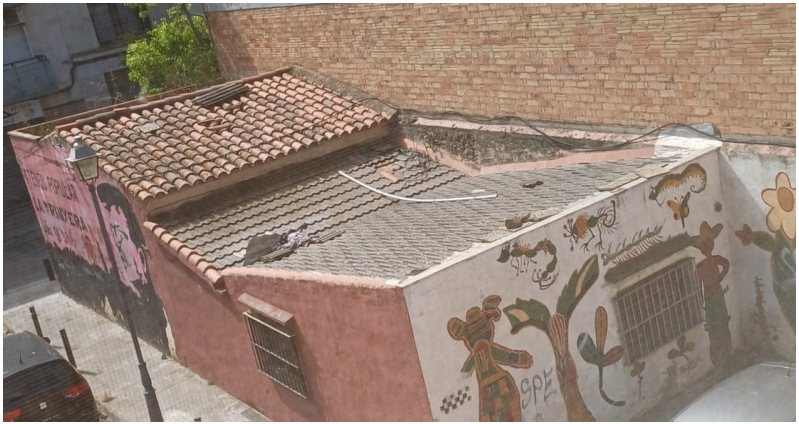
Fig. 4 Edifici a enderrocar
