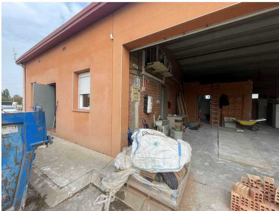
Figura 32. Espai ubicació equips.
