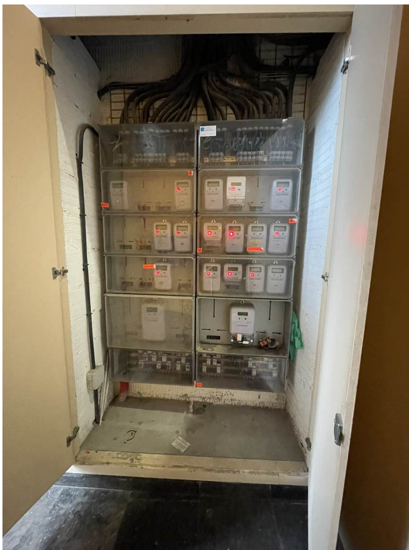
Figura 12. Imatge general centralització existent.
