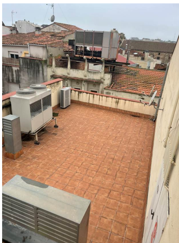
Figura 3. Coberta plana on es situen part dels panells.
