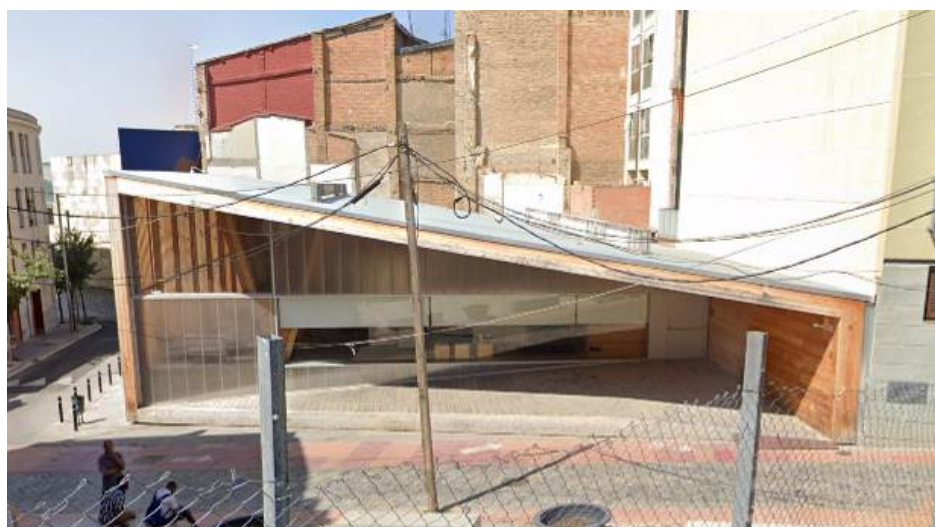
Figura 17. Coberta plana on es situen els panells.
