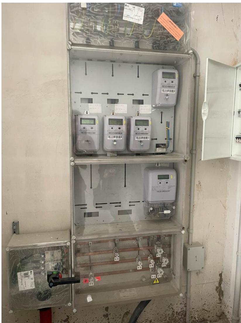
Figura 26. Imatge general centralització existent.
