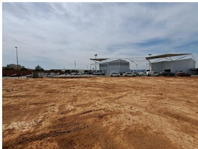
Figura 20. Vista general del solar, una vegada finalitzat el rebaix del sector oest. Orientació oest.
