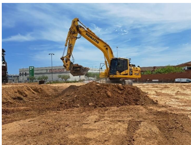
Figura 19. Vista general del procés d'excavació del solar. Orientació sud-est.
