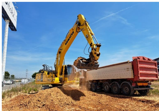
Figura 13. Vista general del procés d'excavació del solar. Orientació nord-oest.
