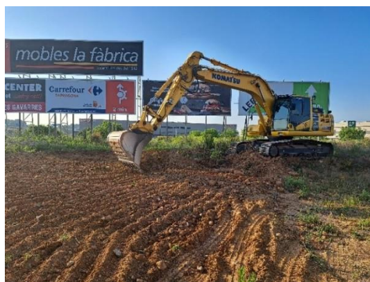
Figura 8. Vista general del procés de desbrossament i neteja del solar. Orientació nord.
