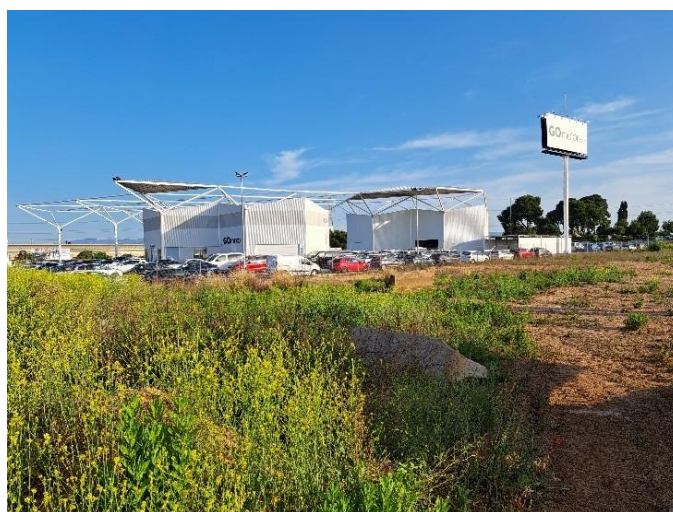
Figura 3. Vista general de la zona objecte dels treballs abans de l'inici de la intervenció. Orientació oest.
