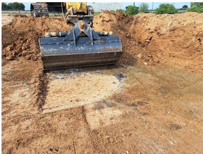
Figura 24. Vista general del procés d'excavació del solar. Orientació sud-est.
