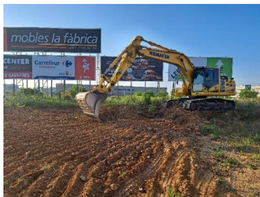
Figura 8. Vista general del procés de desbrossament i neteja del solar. Orientació nord.
