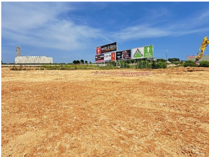
Figura 22. Vista general del solar una vegada finalitzat el rebaix del sector oest. Orientació nord.
