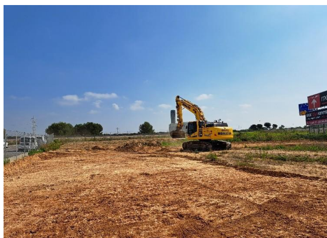
Figura 14. Vista general del procés d'excavació del solar. Orientació nord.
