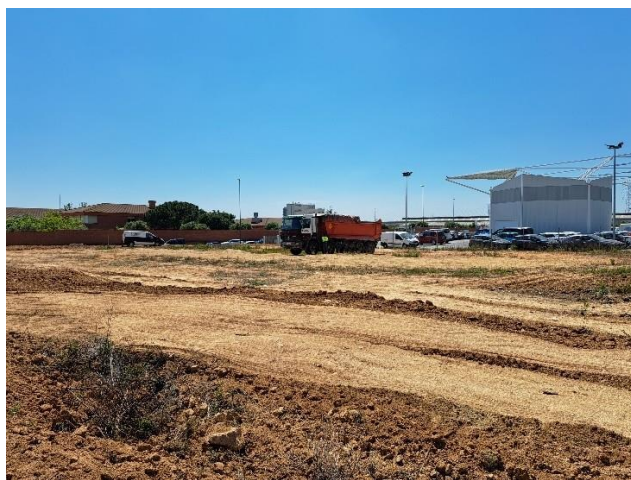
Figura 10. Vista general del procés dels treballs d'excavació del solar. Orientació oest
