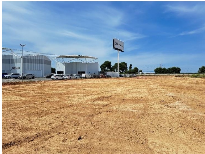
Figura 21. Vista general del solar una vegada finalitzat el rebaix del sector oest. Orientació nord-oest.
