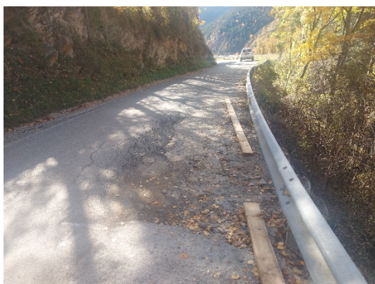
Vista de rotura de la plataforma, p.k. 3+100 (esquerra) i p.k. 3+450 (dreta)
