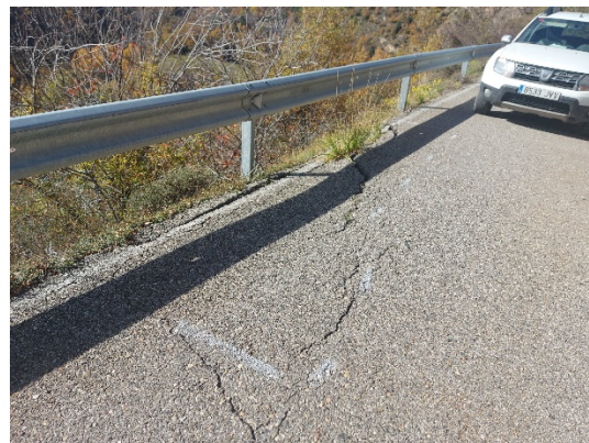
Vista de rotura de la plataforma, p.k. 3+100 (esquerra) i p.k. 3+450 (dreta)
