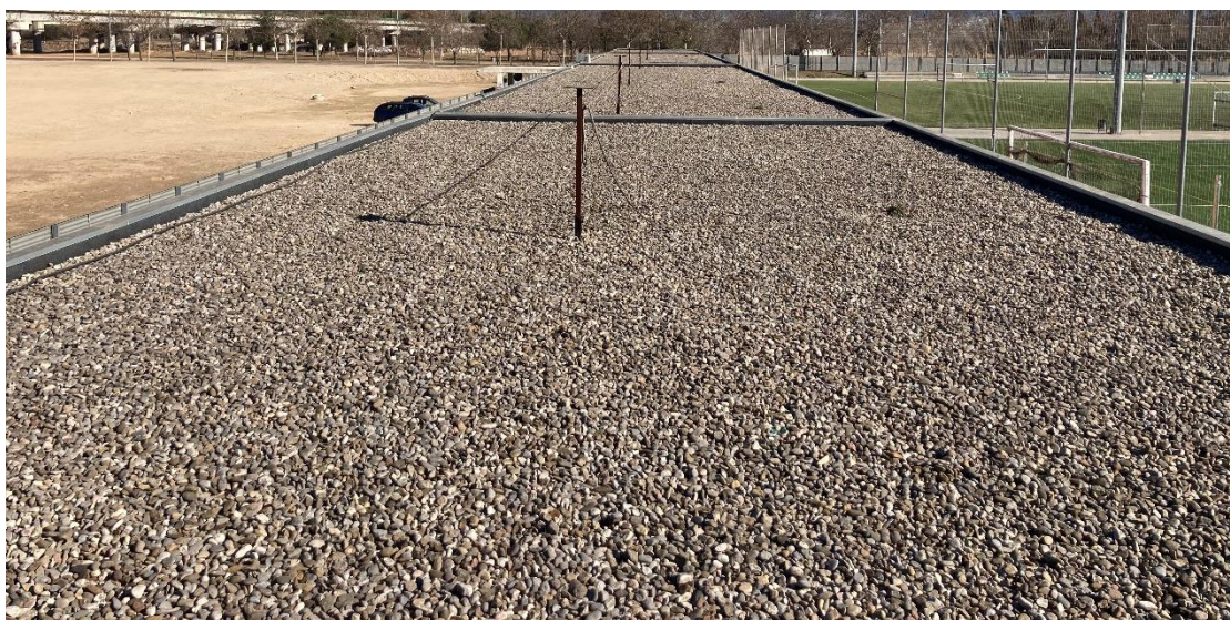
Estat actual de la coberta.
