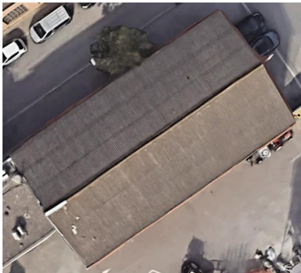
Estat actual de la coberta 3.
