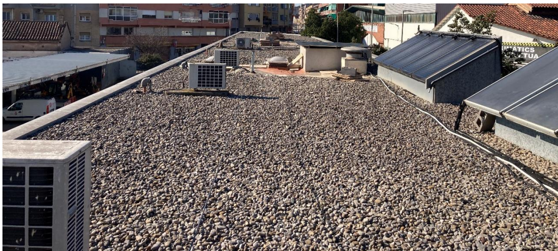
Estat actual de la coberta a incorporar sota dels blocs de formigó (coberta 2).
