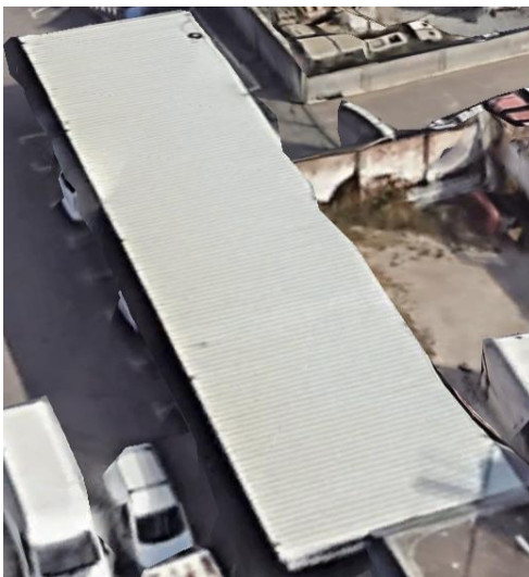
Estat actual de la coberta 1.
