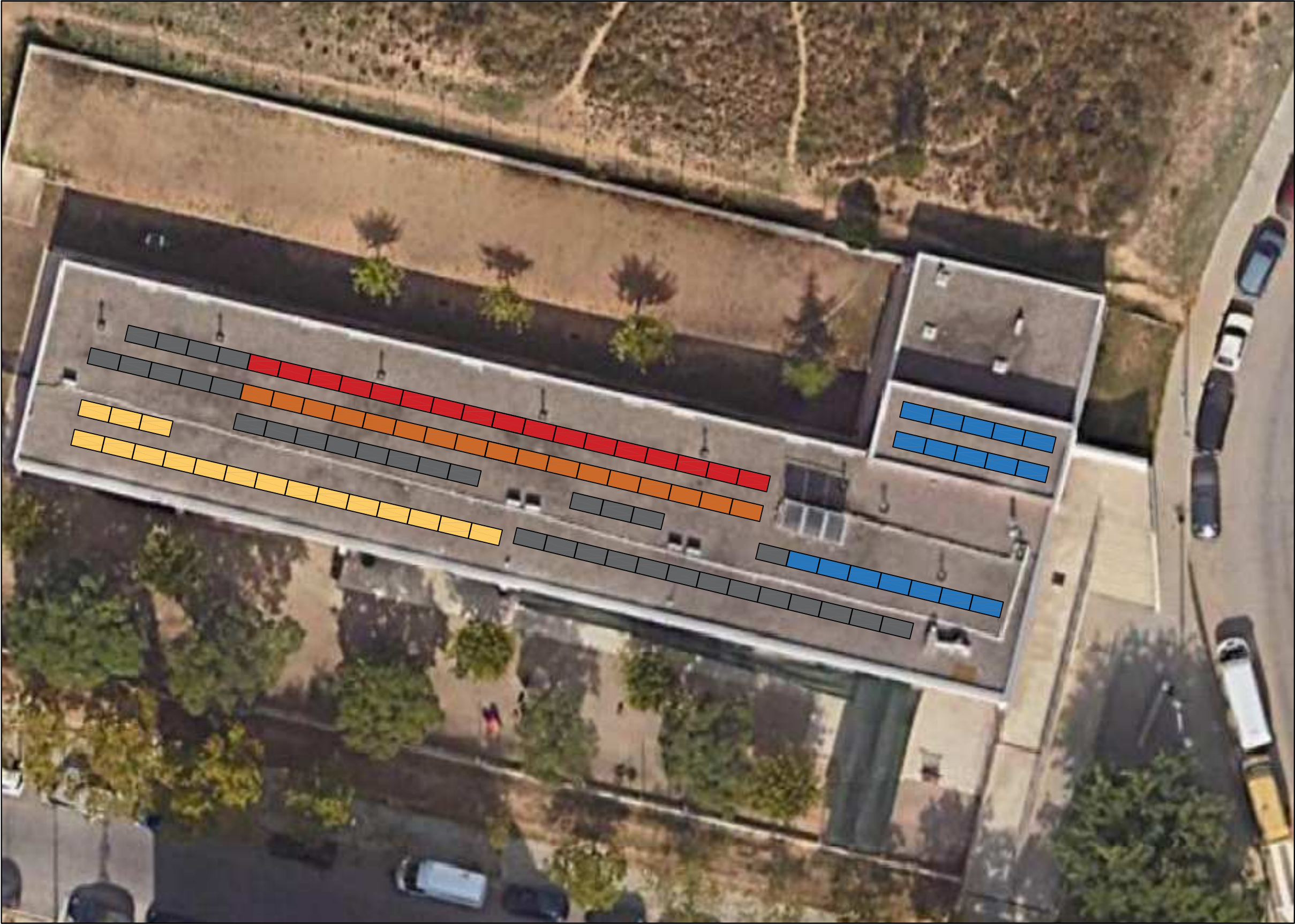
6 sèries de 17 panells, total 102 panells
