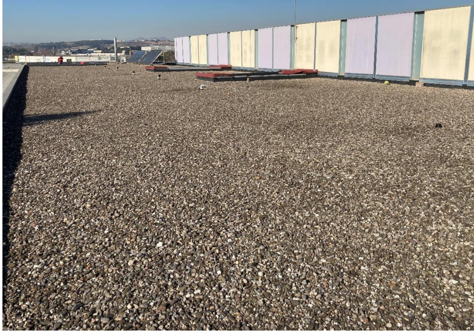
Estat actual de la coberta a incorporar sota dels blocs de formigó.
