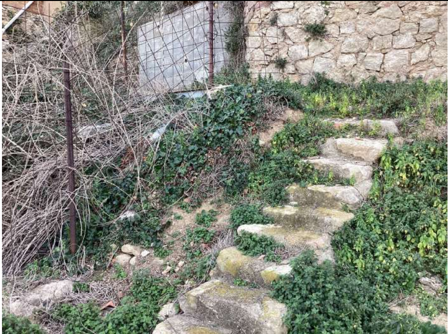
Imatge 15.- elements arquitectònics trobats al llarg del recorregut del tram a Urbanitzar com a carrer de vianants
