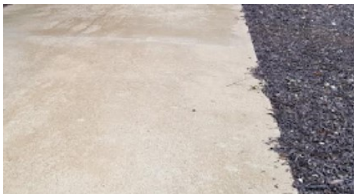
Paviment en base d'asfalt de color a tall net amb el terreny natural
