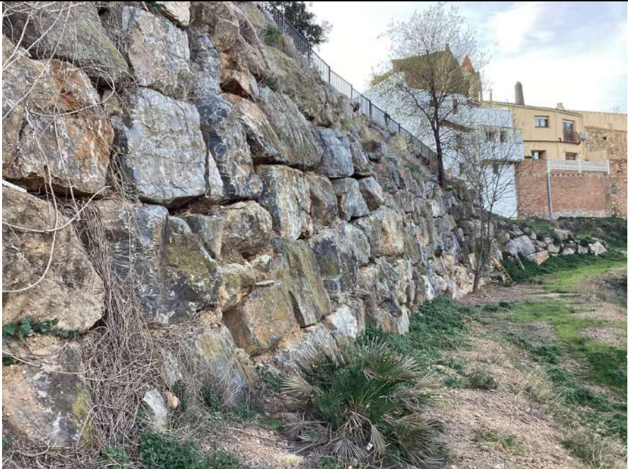
Imatge .- mur d'escullera de suport del Cr de l'església
