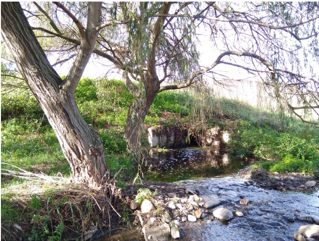
Figura 17 Actual sortida de l'EDAR en el marge dret de la riera. Tram C (vista aigües amunt)
