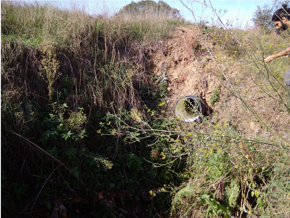
Figura 8 Sortida del sobreeixidor d'aigües residuals. Tram A
