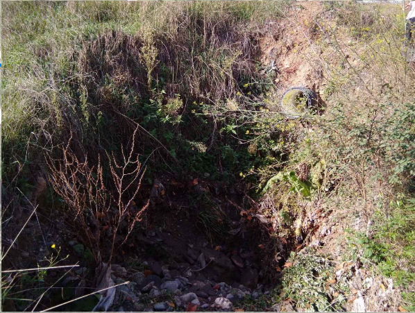
Tram A. Sortida de canalització
