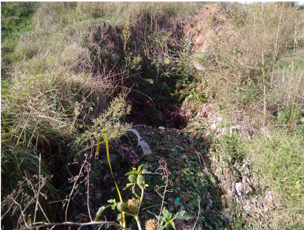
Figura 9 Sortida del sobreeixidor d'aigües residuals. Tram A
