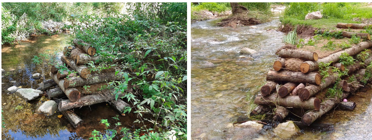
Figura 28 Deflectores amb entramat Krainer executats per Naturalea
