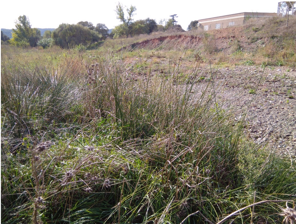
Figura 11 Vista general del marge dret de la riera de Vallserena. Tram B (vista aigües avall)
