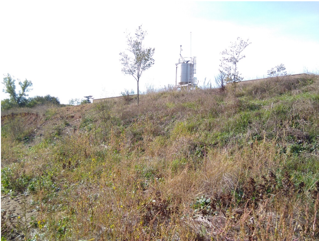
Figura 10 Vista general del marge dret de la riera de Vallserena. Tram B (vista aigües avall)
